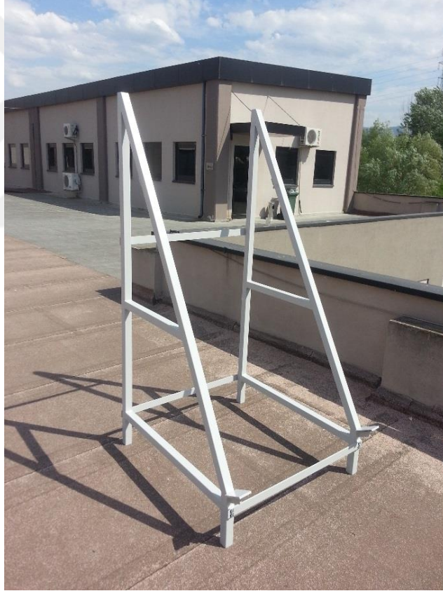
Şekil 4.11. Kollektörlerin üzerine yerleştirildiđi kollektör sehпасı
