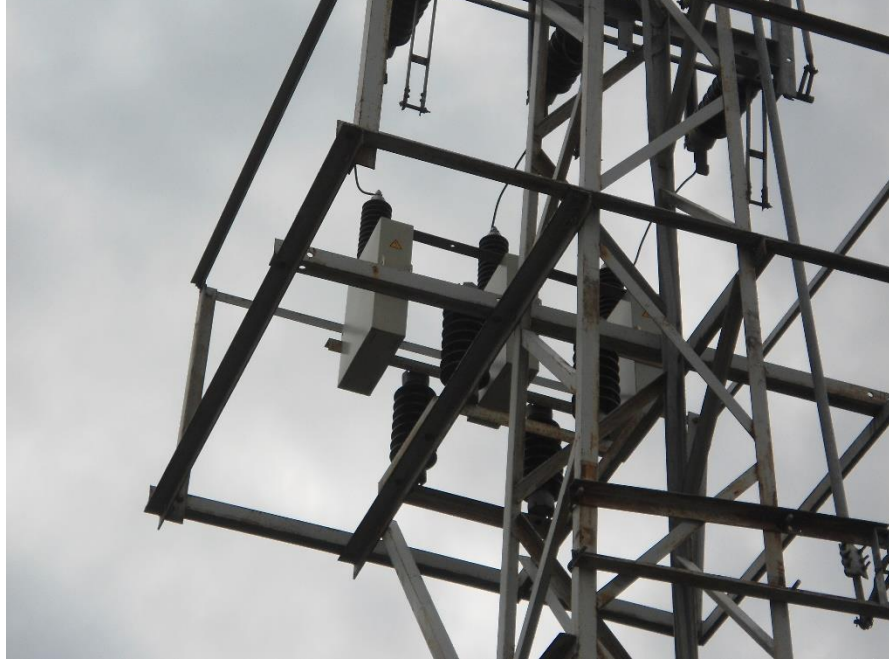
Şekil 1.3. Direk tipi sabit grup şönt kapasitör
