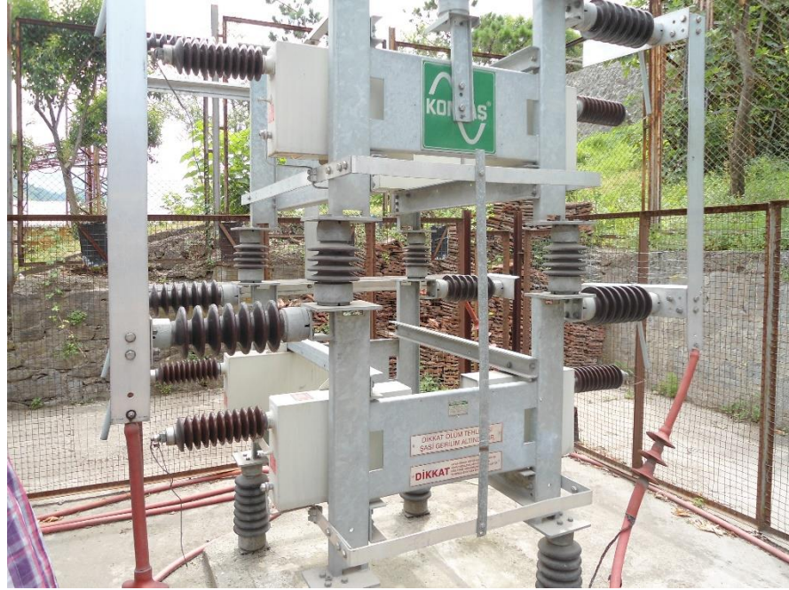
Şekil 1.4. Şalt tipi tek grup şönt kapasitör
