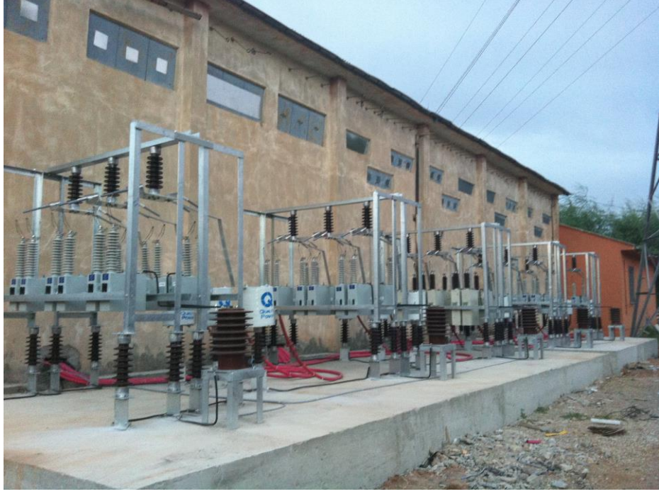
Şekil 1.5. Şalt tipi kademeli grup kapasitör
