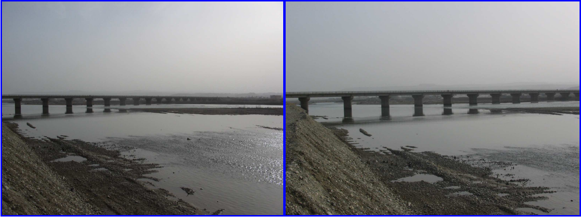
Şekil 2.4.1.5. V. örnekleme istasyonundan bir görünüm
