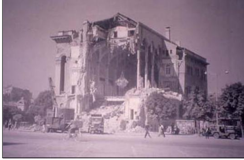
Şekil 3.3. 1963 Üsküp Depreminde hasar görmüş bir bina [22]
