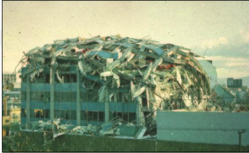
Şekil 3.2. 1985 Meksika Depreminde hasar görmüş bir bina [22]
