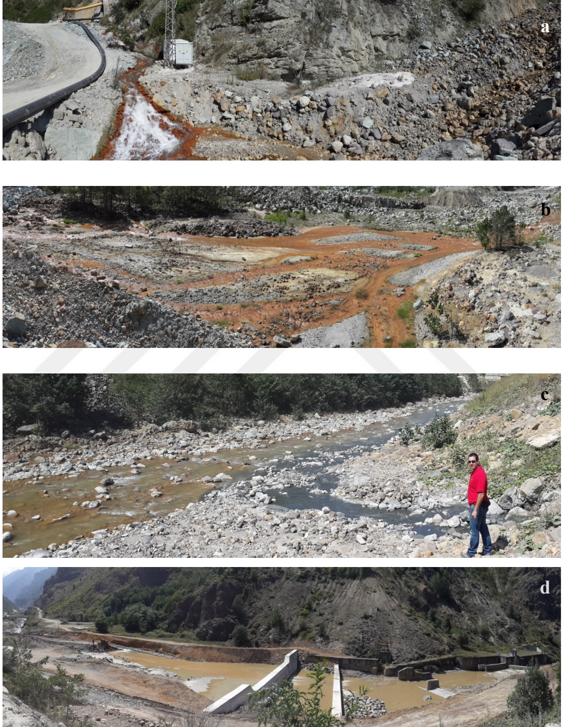
Şekil 3.29. Ağustos-2013 döneminde, a- Lepüsküredere vadisi Murgul Deresi kesişim noktasında açılmış tahliye galerisi, b- Galeriden boşalan demirce zengin suyun dere yatağını kırmızıya boyaması, c- Cevher üretim tesisinden sızan ve Murgul Deresi'ne boşalan flotasyon atık suyu, d- DSİ tarafından Murgul Deresi üzerinde yapılan ıslah çalışmaları
