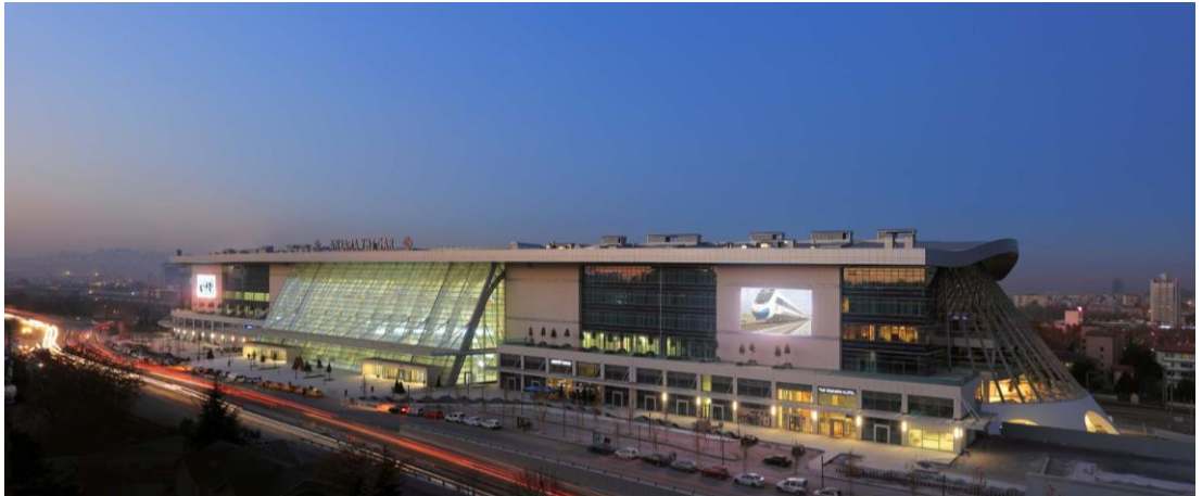
Şekil 3.23. Ankara gar binası (URL-11)
