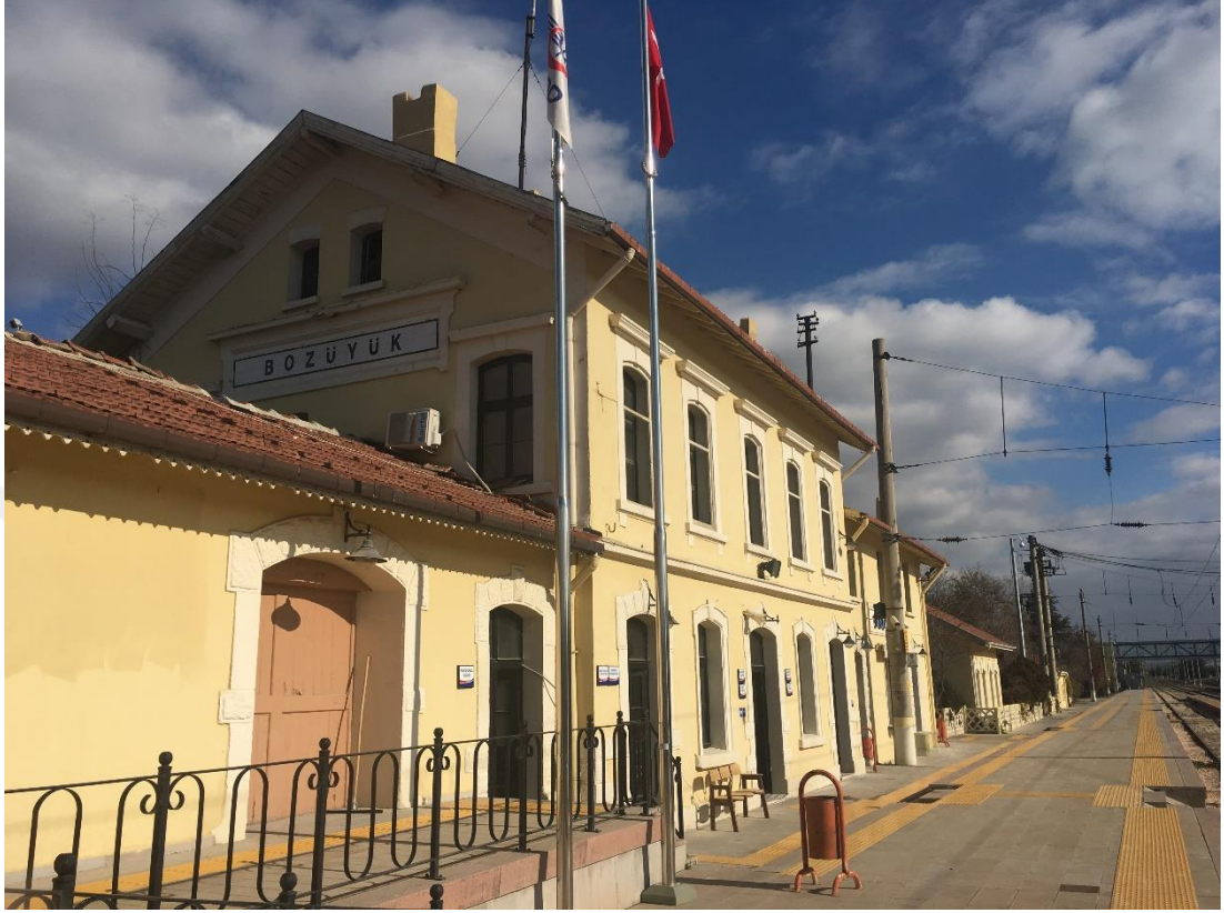
Şekil 3.12. Eski Bozüyük istasyon binası (Yazarın arşivinden eklendi)
