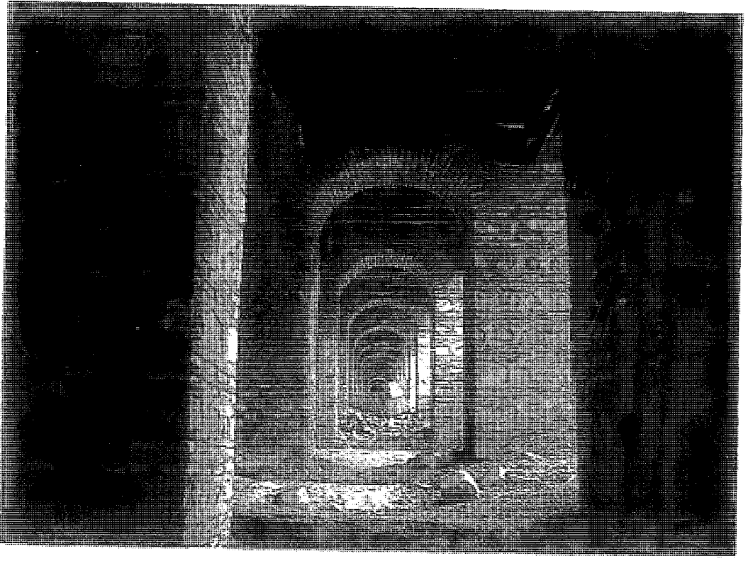
Resim 142: Aşağı Kervansaray'ın ikinci kat revakları (güneyden)
