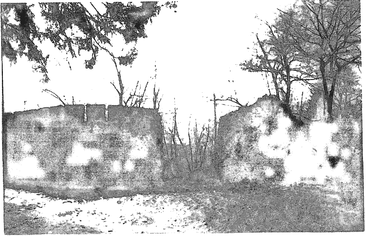
Resim 68: Şeki Kalesi, kuzey cephe girişi
