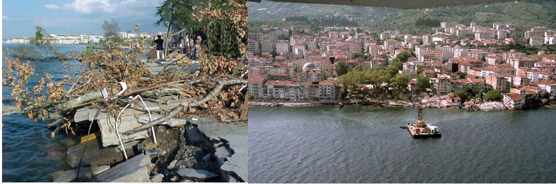
Şekil 3.4. Değirmendere burnunda gözlenen zemin yenilmesi (URL-2)
