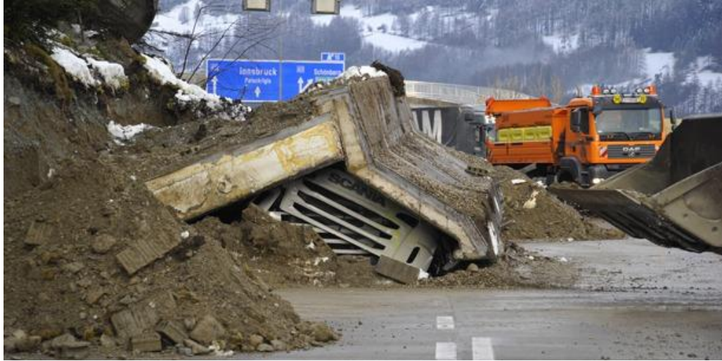
Şekil 1.7. Avusturya'da bir istinat duvarı yenilmesi
