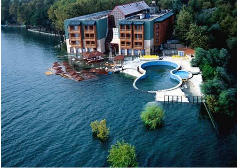
Şekil 3.6. 1999 Kocaeli depreminde zemin yenilmesi sonucu yıkılan Sapanca Vakıf Oteli (URL-3)
