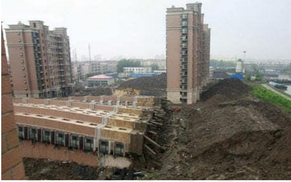
Şekil 1.6. Çin'de taşıma gücü kaybı nedeniyle devrilen 13 katlı binalar
