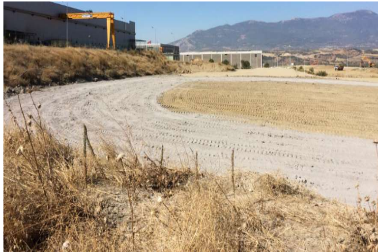
Şekil 3.4. Kireç uygulanan zeminin durumu
