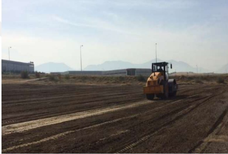
Şekil 3.3. Dolgu malzemesinin sıkıştırılması
