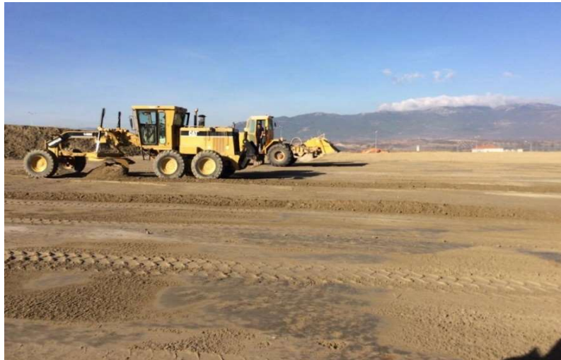
Şekil 3.1. Dolgu malzemesinin serilmesi
