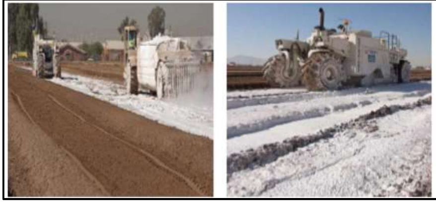
Şekil 1.10. Kireç ile zemin stabilizasyonu uygulaması (Wang ve Reston, 2007)
