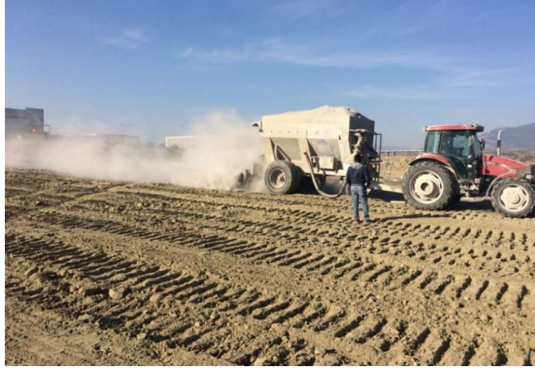
Şekil 3.2. Kirecin zemine uygulanması
