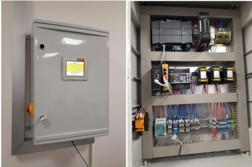
Şekil 4.5. Aydınlatma otomasyon panosu
