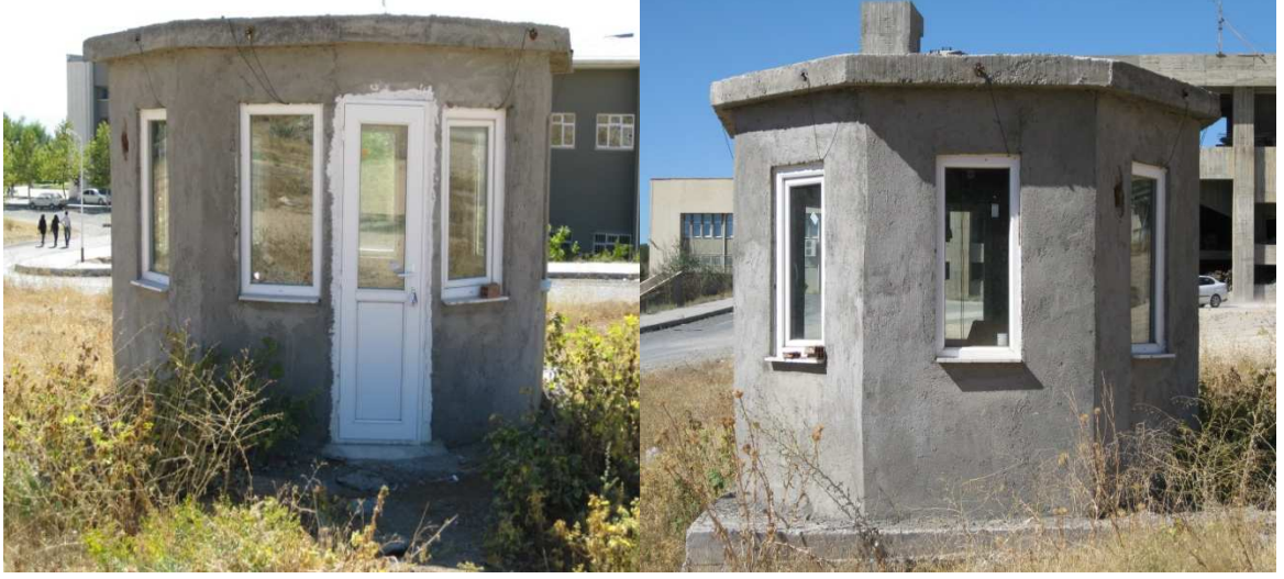
Şekil 3.6. Kapı pencere takılması ve piranometrelerin monte edilmesinden sonra yapının son durumu
