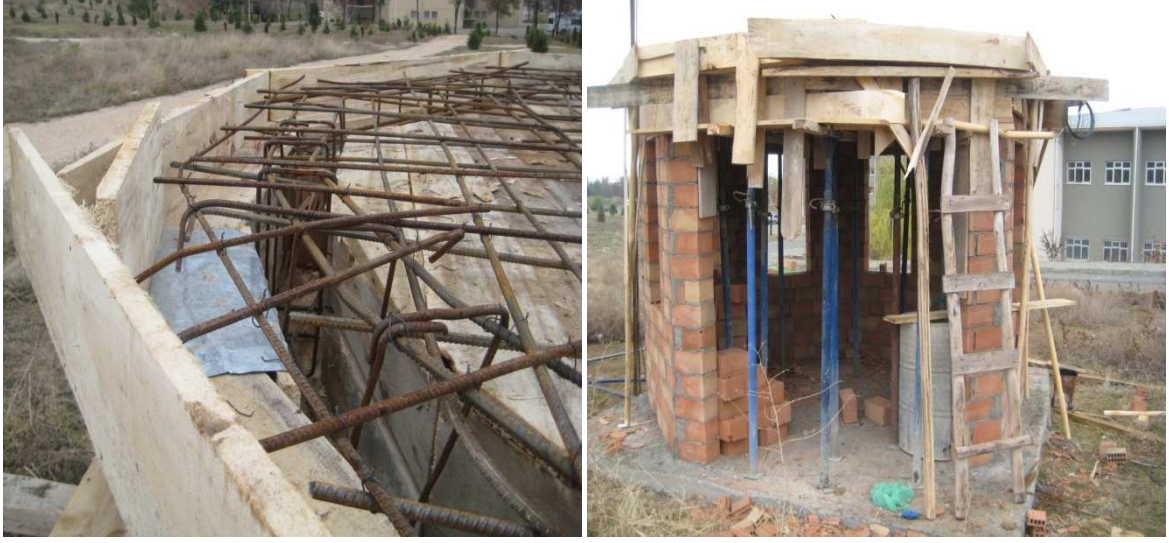
Şekil 3.4. Tavan döşemesinin demir donatılarının döşenmesi ve kalıbın çakılması
