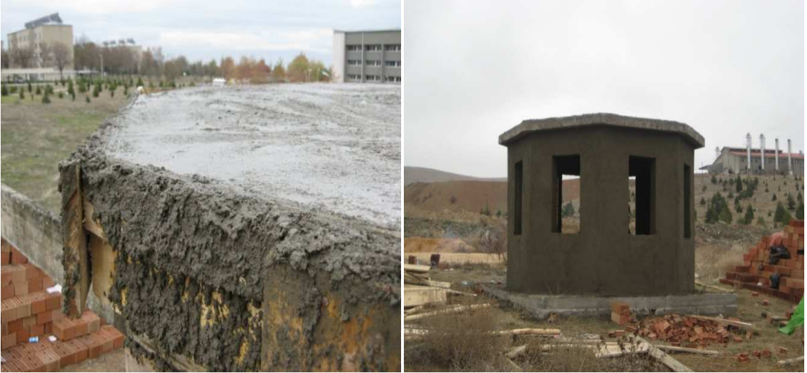
Şekil 3.5. Tavan döşemesinin betonunun dökülmesi ve sıva işleminin bitirilmesi
