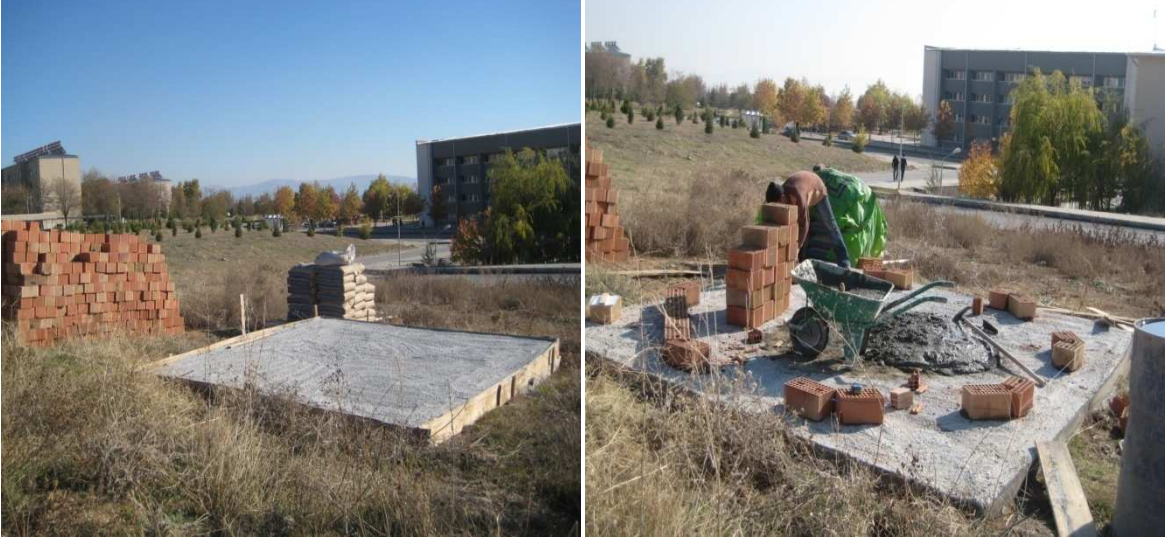
Şekil 3.2. Zemine tesviye amaçlı beton dökülmesi
