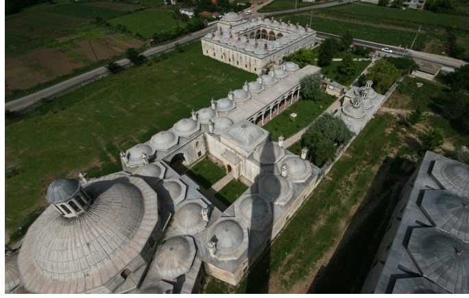
Fotoğraf 42- Darüşşifa ve Medresenin havadan görünüşü
