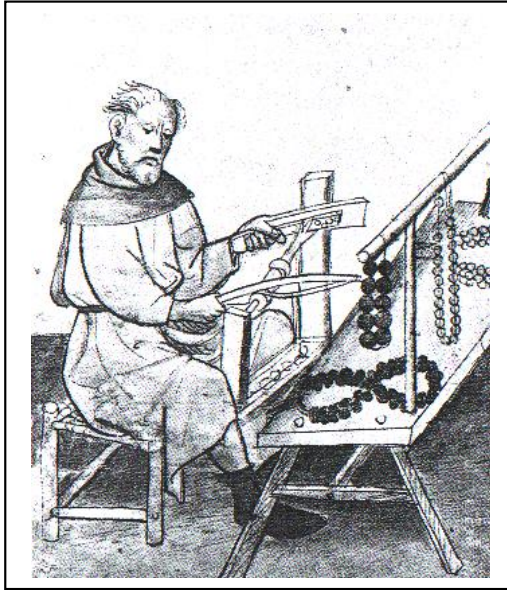
Şekil 8: Basit Bir Torna Tezgâhı
