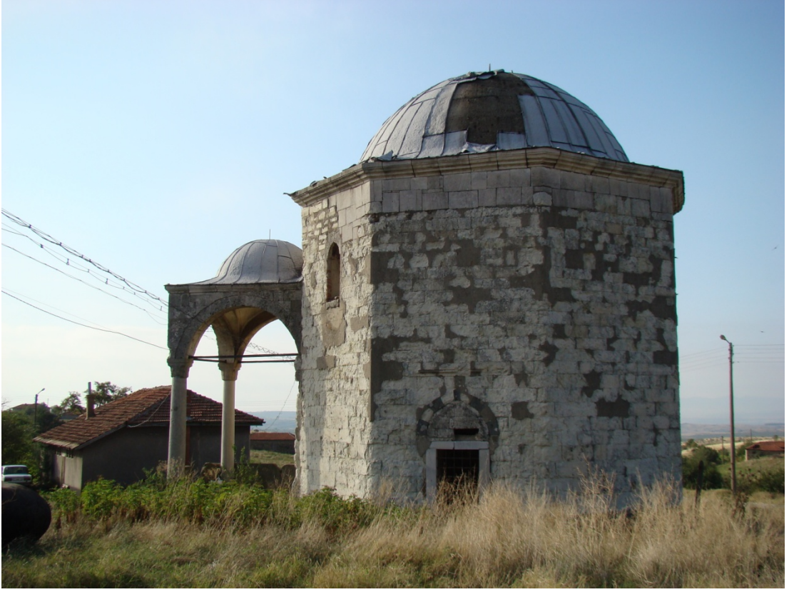
Resim:144- Hızır Baba Türbesi, kuzeyden genel görünüm
