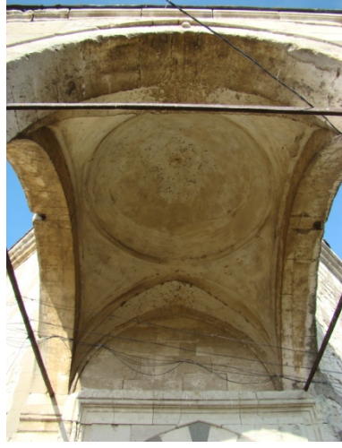
Resim:151- Hızır Baba Türbesi, giriş bölümü kubbe geçişleri
