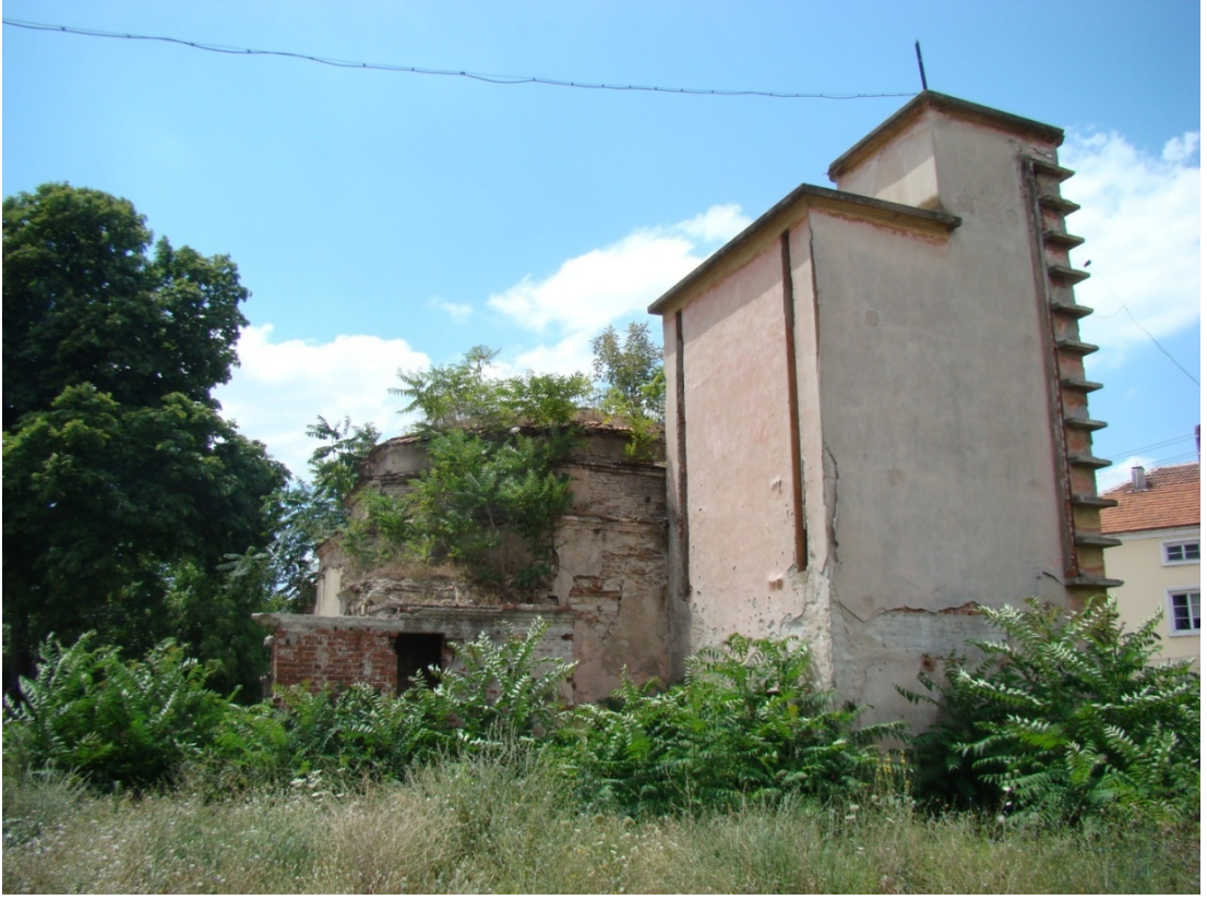
Resim:178- Mustafa Paşa Hamamı, kuzey cephe
