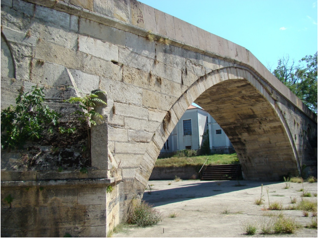
Resim:198- Siyavuş Paşa Köprüsü, orta kemer açıklığı ve mansap tarafı selyaranları
