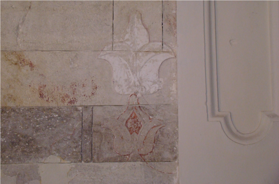
Resim: 85-Sinan Paşa Camisi harimi, kuzey duvarı kalem işi süslemesi
