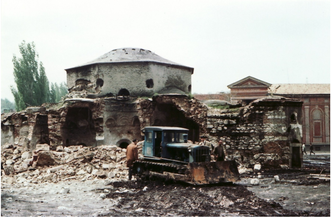
Resim:229- Hasköy Hamamı, batı cephe yıkımı (H.M. Arşivi'nden)
