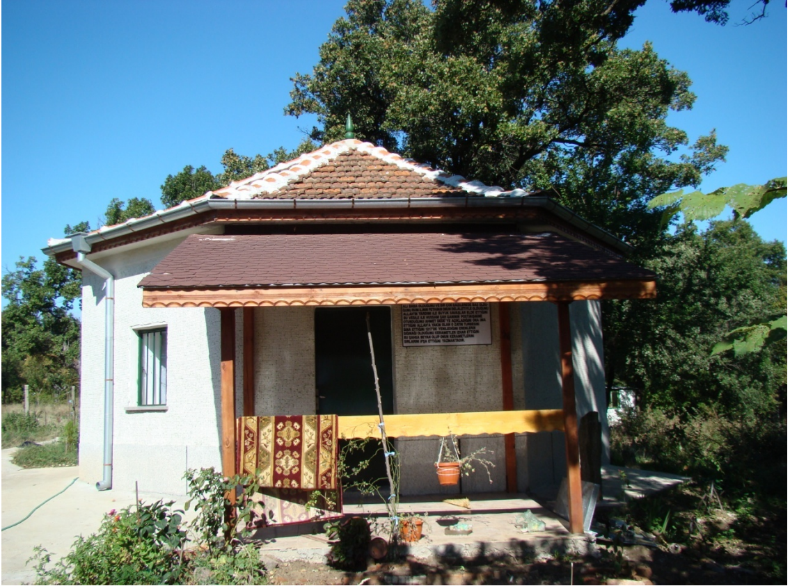
Resim:167- Demirhanlı Ali Baba Türbesi, güney cephe
