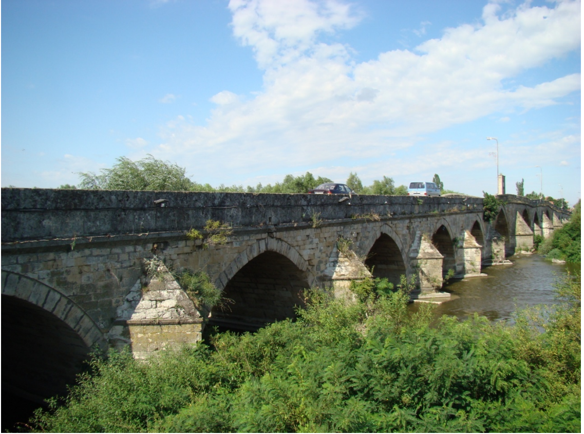
Resim:185- Mustafa Paşa Köprüsü, memba tarafına kuzeydoğudan bakış
