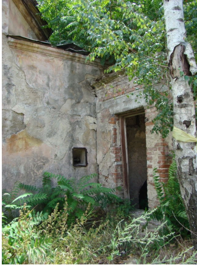
Resim:177-Mustafa Paşa Hamamı, batı cephe giriş açıklığı
