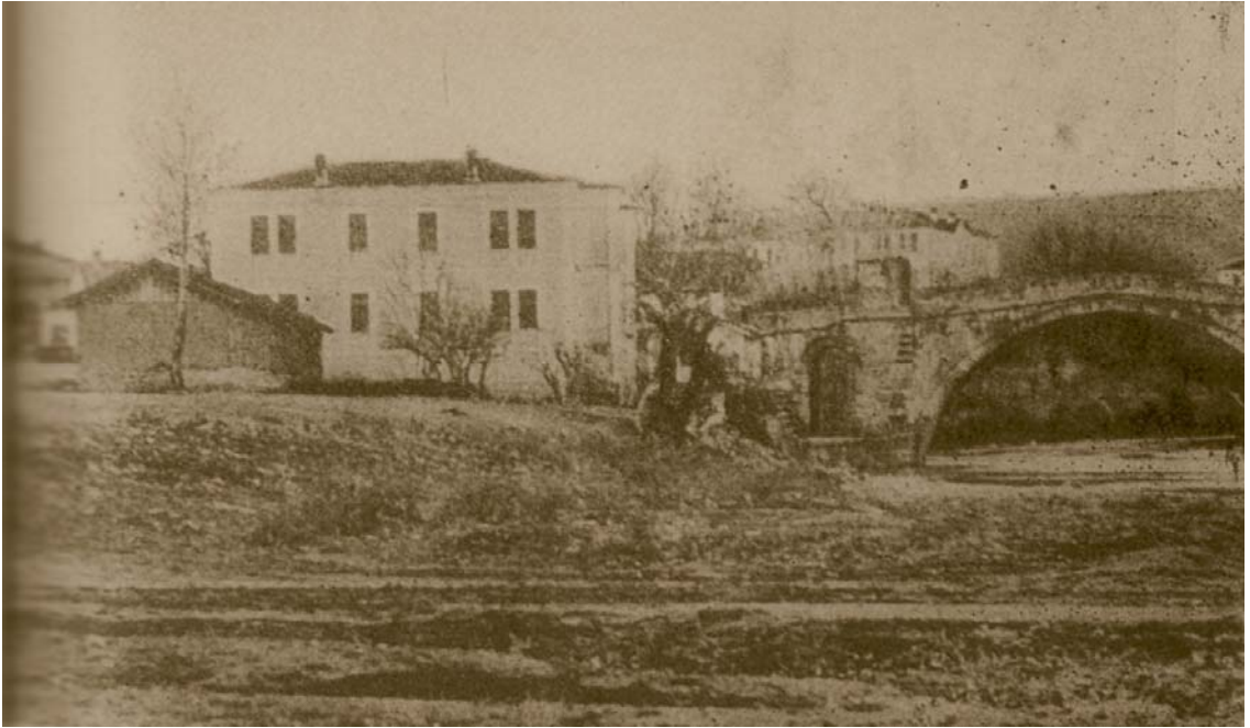
Resim:193- Siyavuş Paşa Köprüsü, memba tarafından orta kemer açıklığına bakış (K. Dinkov'dan)
