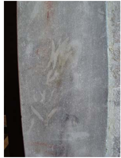
Resim:91-Sinan Paşa Camisi, batı cephe alt sıra pencere süslemesi
