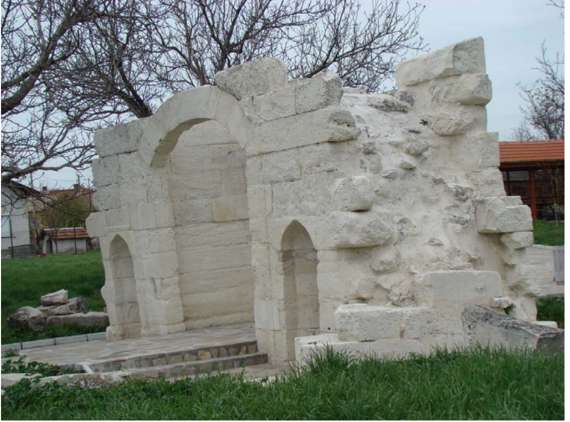
Resim: 248- Sinan Paşa Hanı, duvar dolgusu
