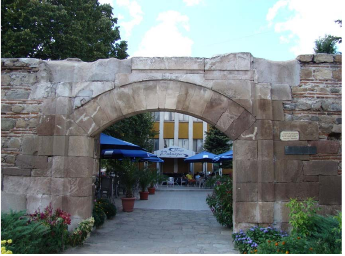
Resim: 238- Harmanlı Kervansarayı, görçenliğe geçiş açıklığı
