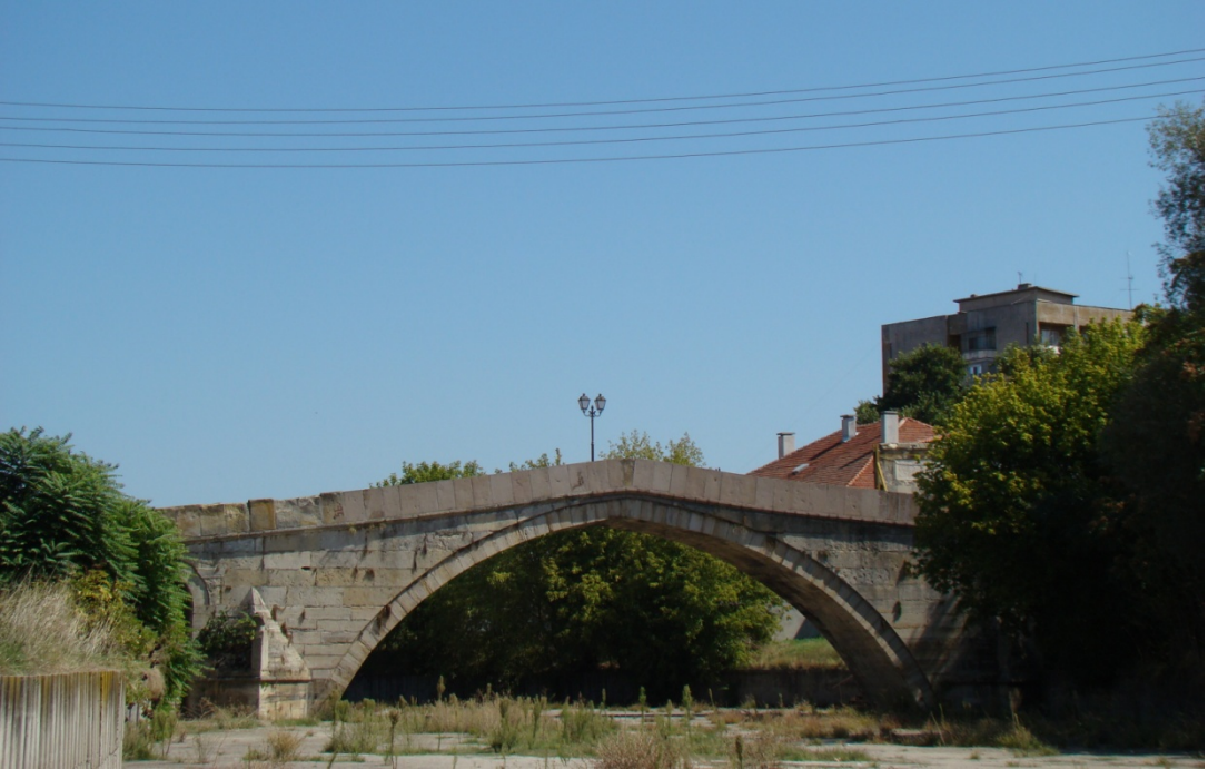
Resim:197- Siyavuş Paşa Köprüsü, orta kemer açıklığı mansap tarafından görünüş
