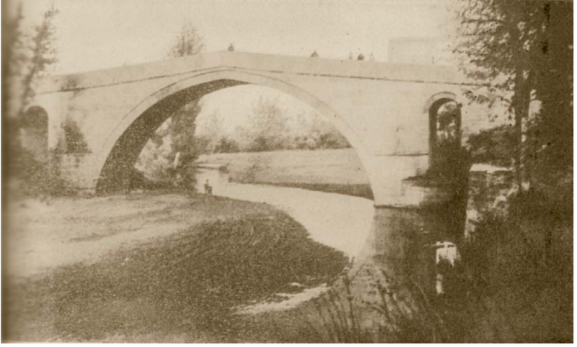
Resim:192- Siyavuş Paşa Köprüsü, mansap tarafından orta kemer açıklığına bakış (K. Dinkov'dan)
