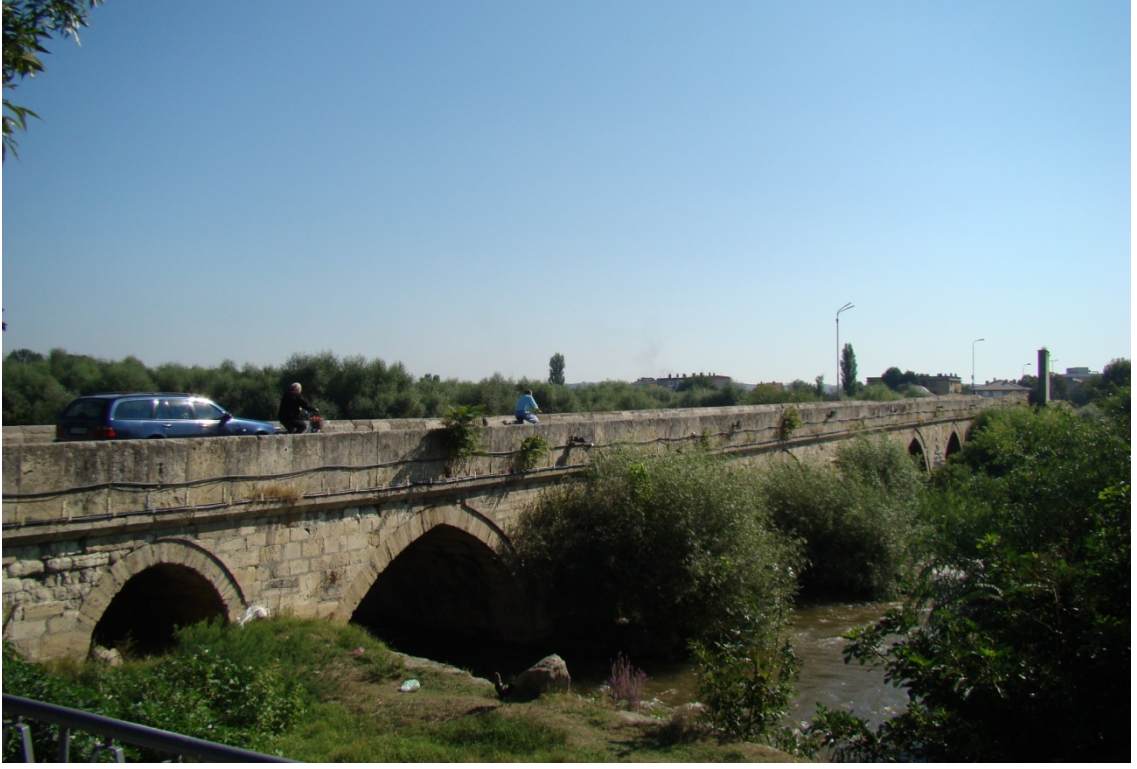
Resim:184- Mustafa Paşa Köprüsü, mansap tarafına güneybatıdan bakış
