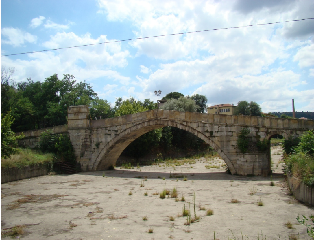
Resim:196- Siyavuş Paşa Köprüsü, orta kemer açıklığı memba tarafından görünüş
