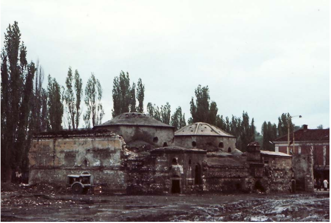
Resim:223- Hasköy Hamamı, güneybatıdan genel görünüm (H.M. Arşivi'nden)
