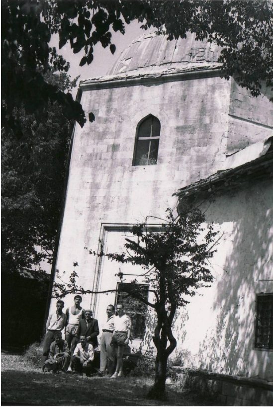
Resim:104-Otman Baba Türbesi, restorasyon öncesi güneydoğu cephe (H.M. Arşivi'nden)
