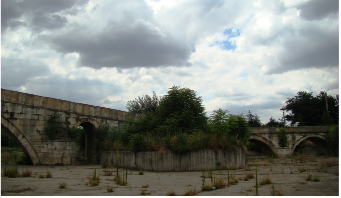
Resim:200- Siyavuş Paşa Köprüsü tahliye kemerleri, memba tarafından görünüş
