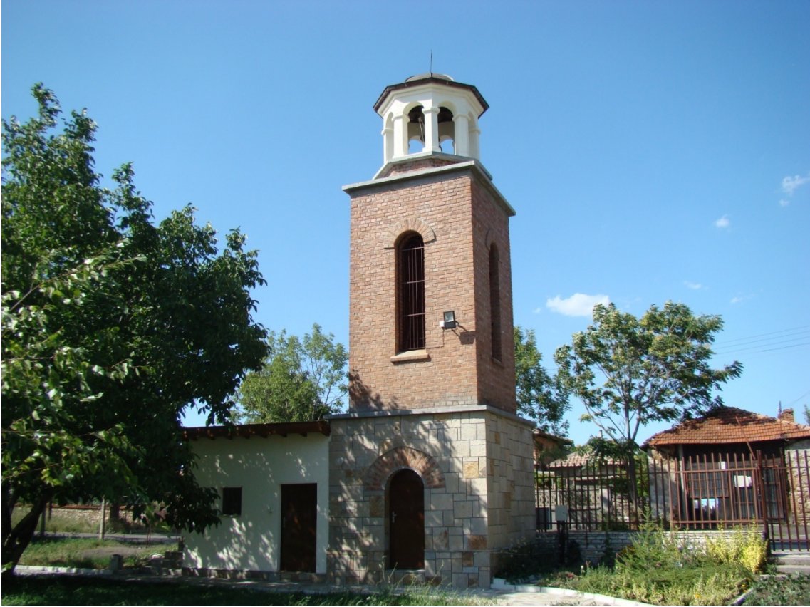
Resim:216- Uzuncaova Saat Kulesi, güney cephe
