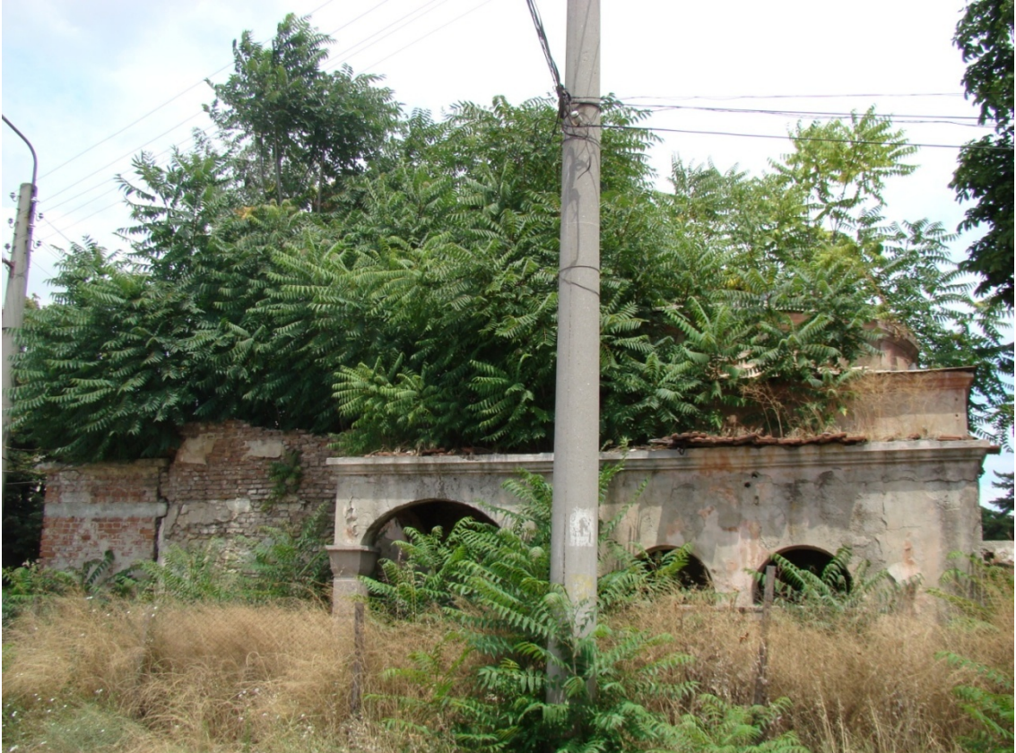
Resim:173- Mustafa Paşa Hamamı, güney cephe
