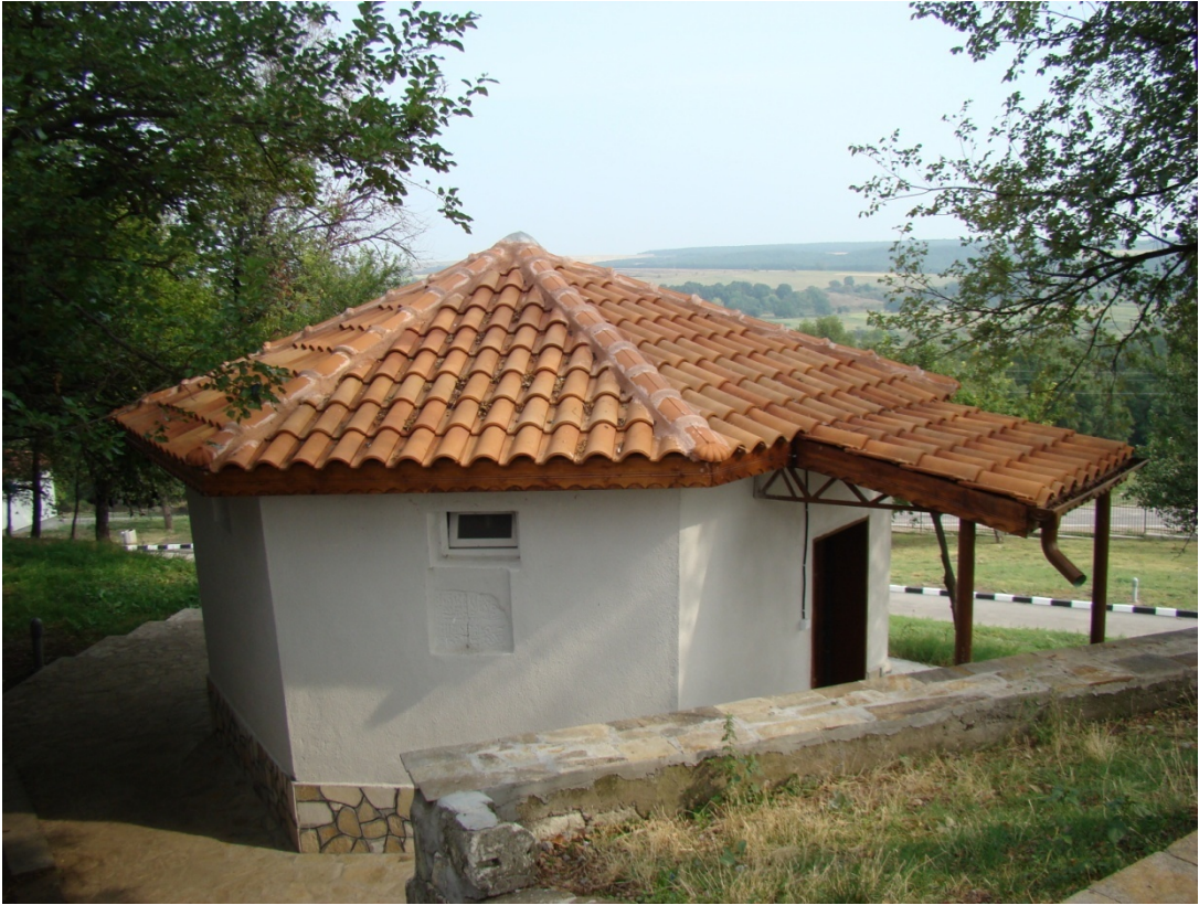
Resim: 138- Hasan Hüseyin Türbesi, batı ve güney cepheler
