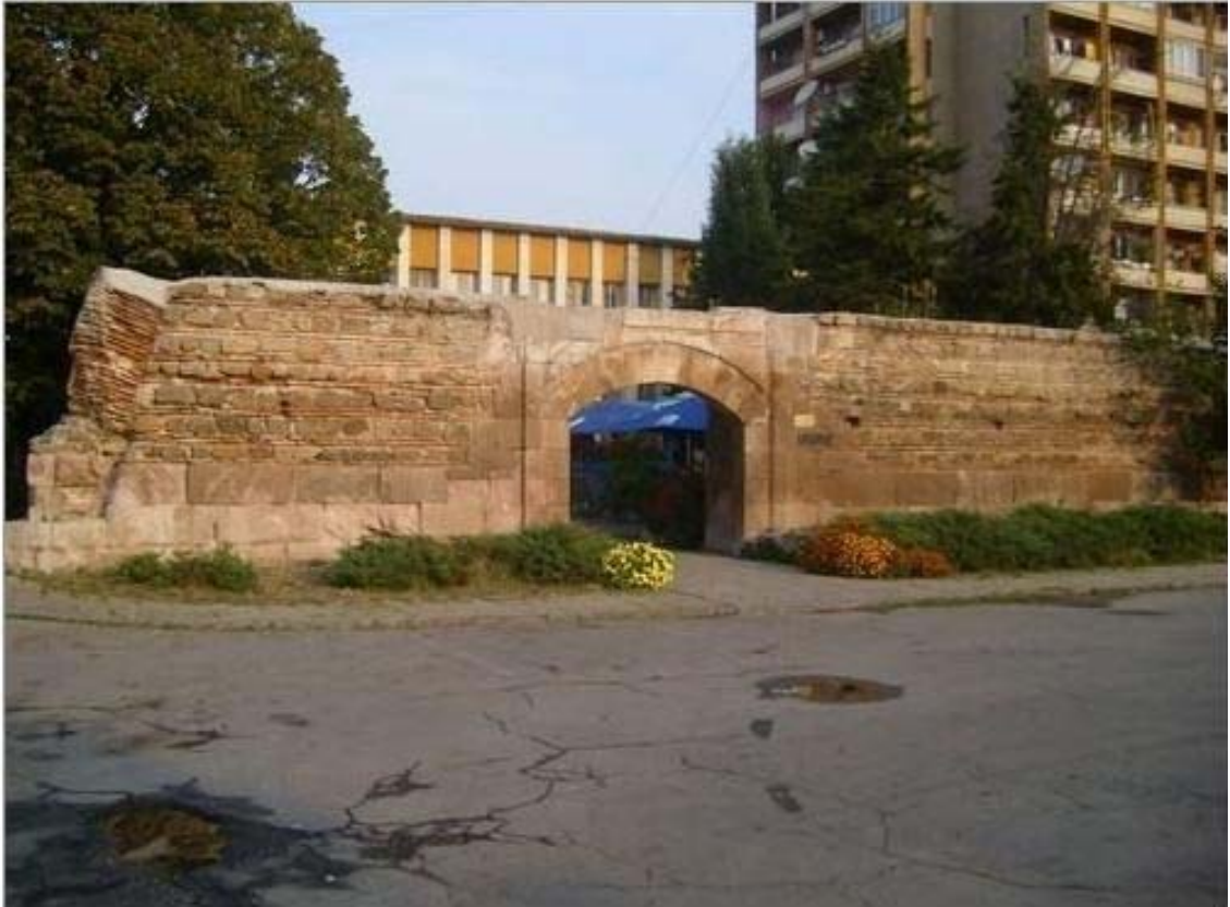
Resim: 237- Harmanlı Kervansarayı, görçenlik duvarı kalıntısına kuzeydoğudan bakış
