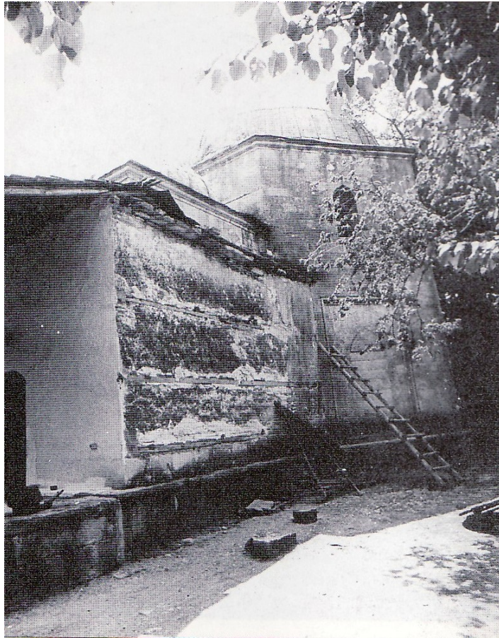
Resim:109-Otman Baba Türbesi, kuzeydoğu cephe ve giriş bölümü (L. Mikov'dan)
