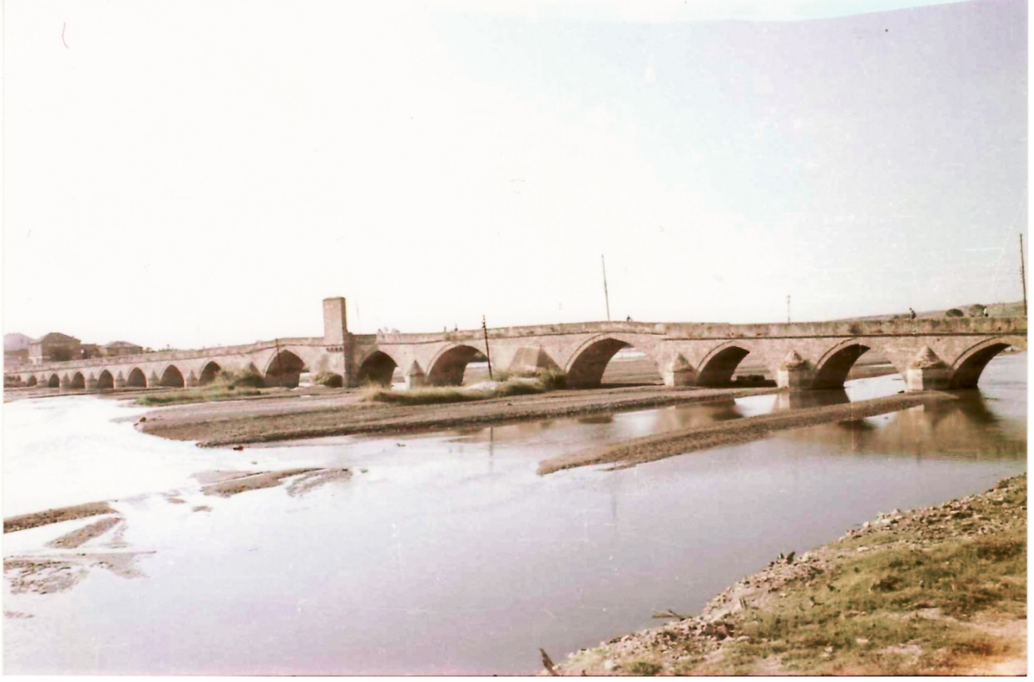
Resim:182- Mustafa Paşa Köprüsü, mansap tarafına güneydoğudan bakış (H.M. Arşivi'nden)
