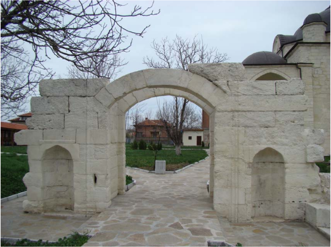
Resim: 247- Sinan Paşa Hanı, giriş açıklığı ve duvar kalıntısının güneyden görünüşü
