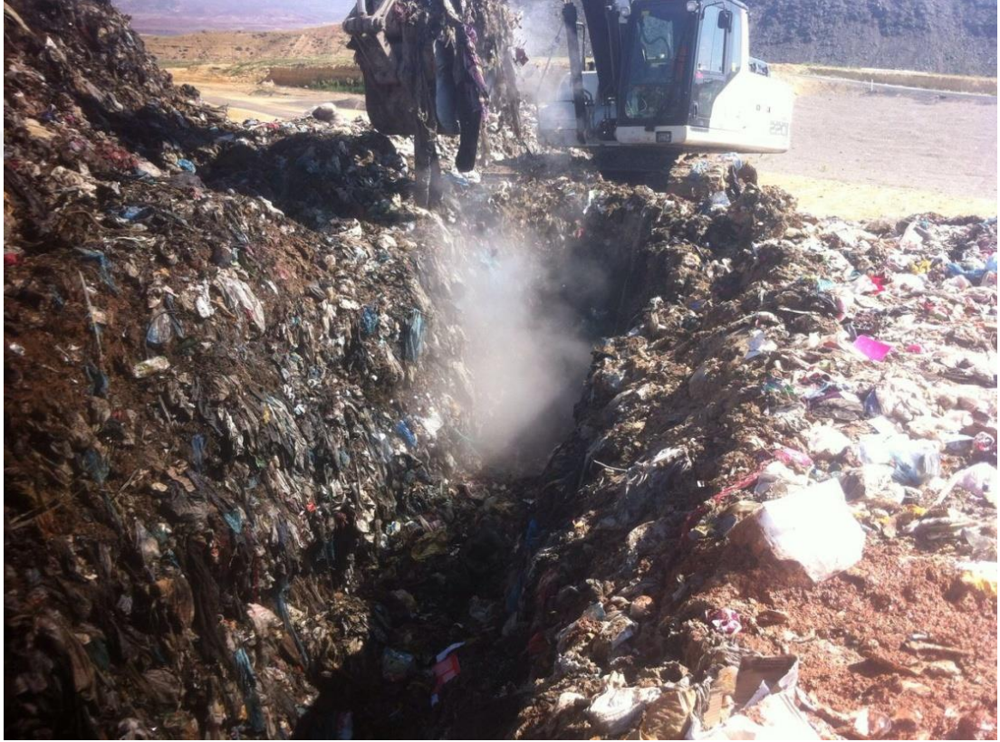
řekil 5.18. Gaz emiř sisteminin uygulanması iin gerekli hazırlık alıřmaları
