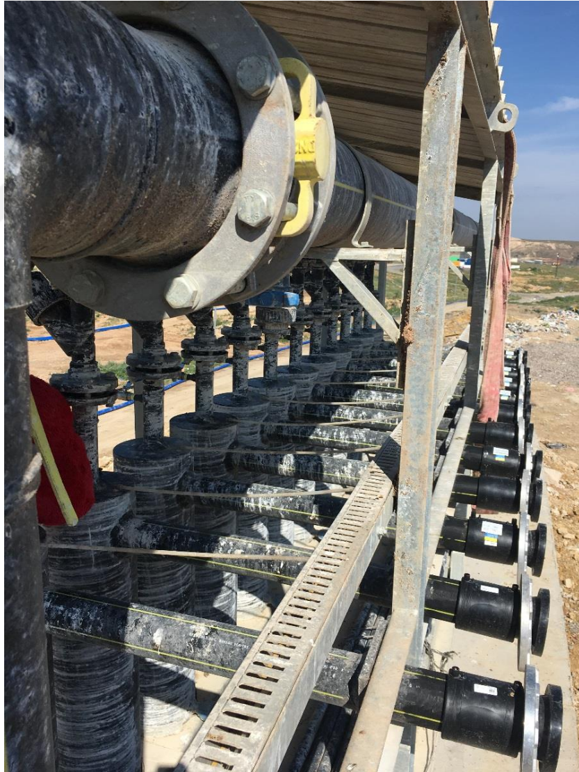
Şekil 5.39. Rigollerden gaz toplama istasyonlarına olan emiş borusu bağlantısı
