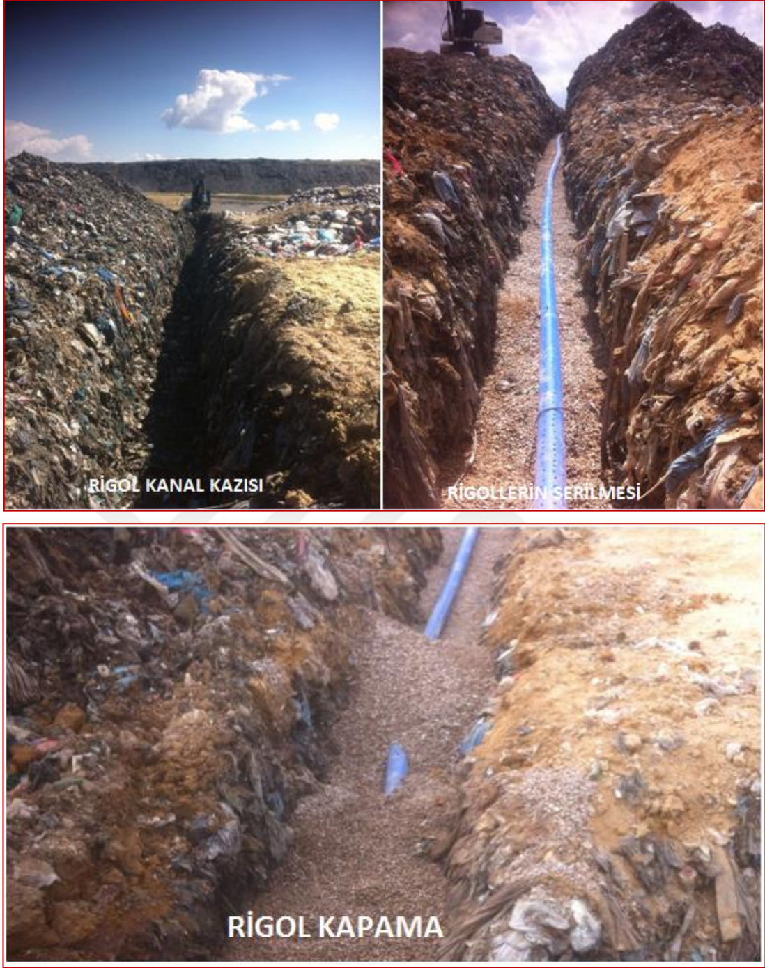
Şekil 5.24. Rigol kanalı açma, boru serme ve kanal kapama işlemleri uygulanması
