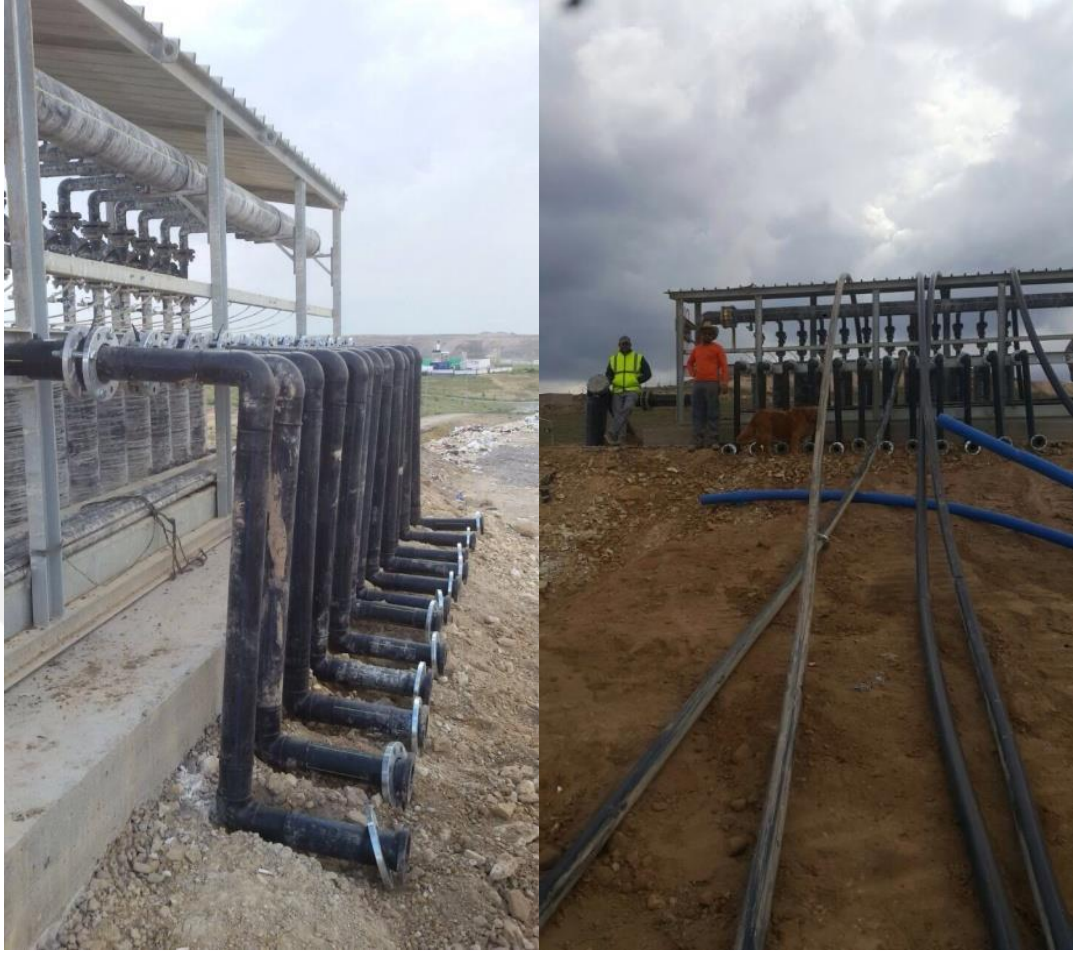
Şekil 5.40. Gaz toplama istasyonları Z lerin montajı ve emme borularıyla irtibatlanması
