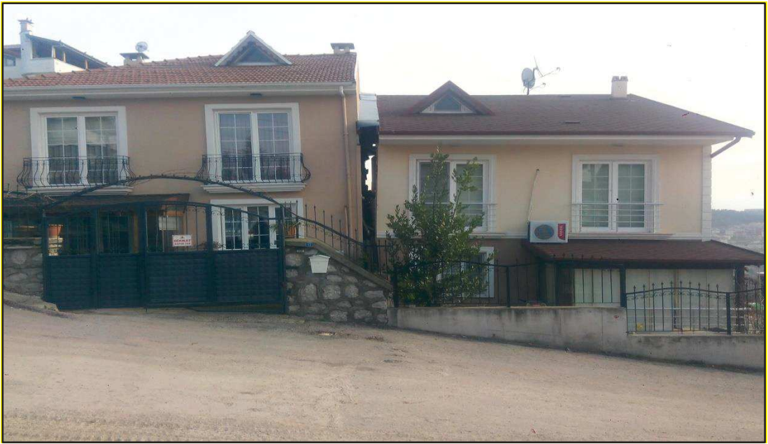
Şekil 5.5. Parselin kuzey kısmındaki hasar gören binaların görüntüsü
