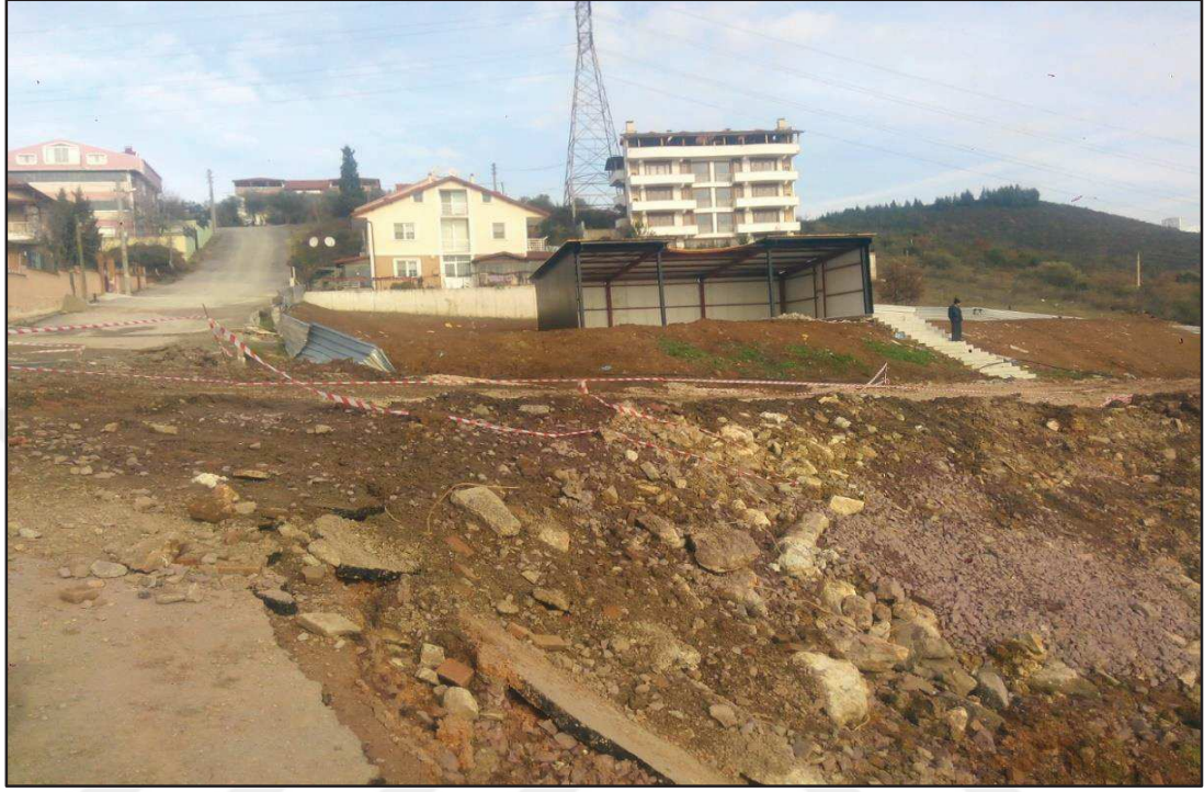
Şekil 5.2. Parselin kuzey cephesinde bulunan yolda oluşan kaymalar
