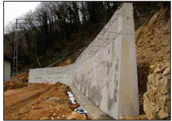
Şekil 4.8. Betonarme konsol İstinat duvarı
