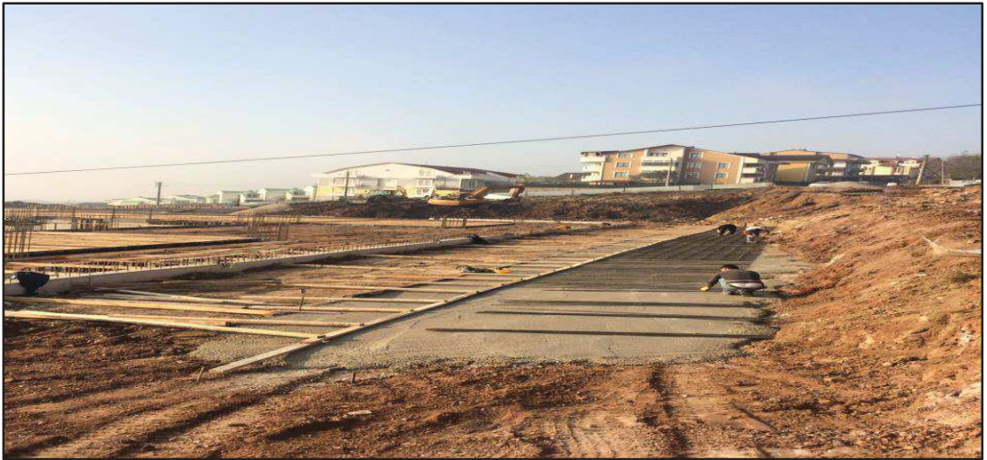
Şekil 5.13. Önlem için yapılan istinat duvarı çalışması
