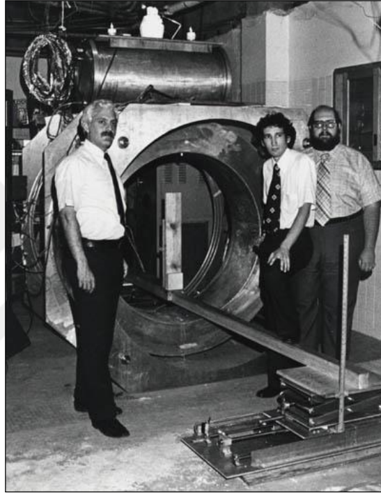
Şekil 3.3. Damadian ve arkadaşları tarafından üretilen ilk MR makinesi [22]
