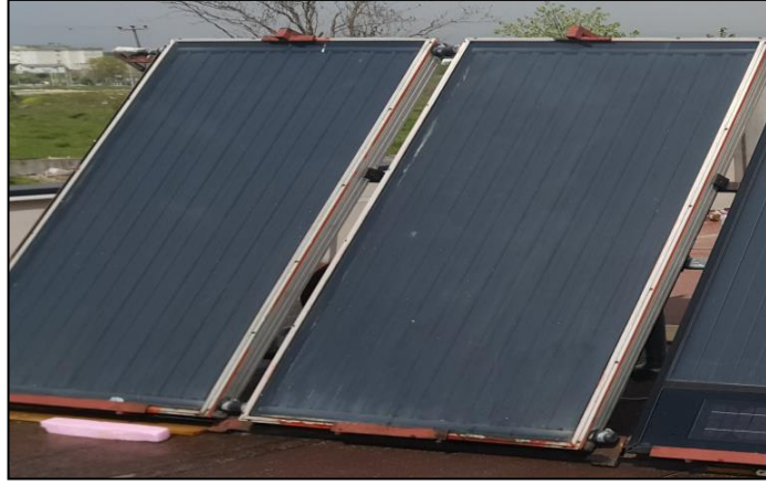
Şekil 4.7. Su akışkanlı güneş kolektörü
