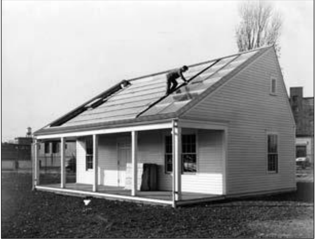
Şekil 3.2. Solar I adı verilen ve Amerika'da yapılmış güneşle ısıtılan ilk ev olarak kabul edilen yapı [27]
