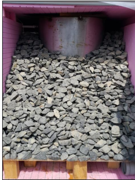
Şekil 4.14. Isı deposunun termal kamera ile çekim yapılan yüzeyi
