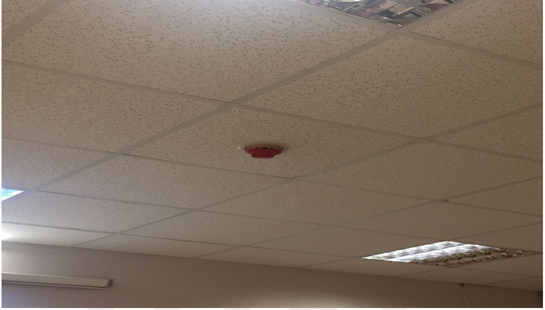
Şekil 4.15. Kapağı kapalı duman dedektörü.
