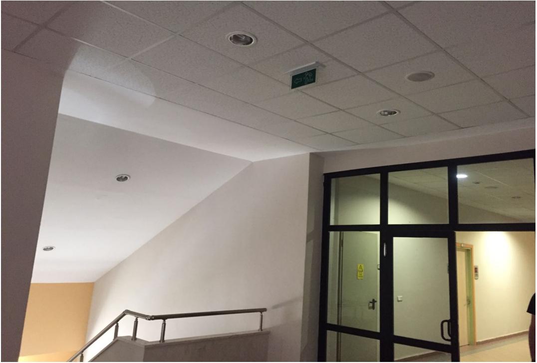
Şekil 4.4. Işığı yanmayan acil çıkış levhası.
