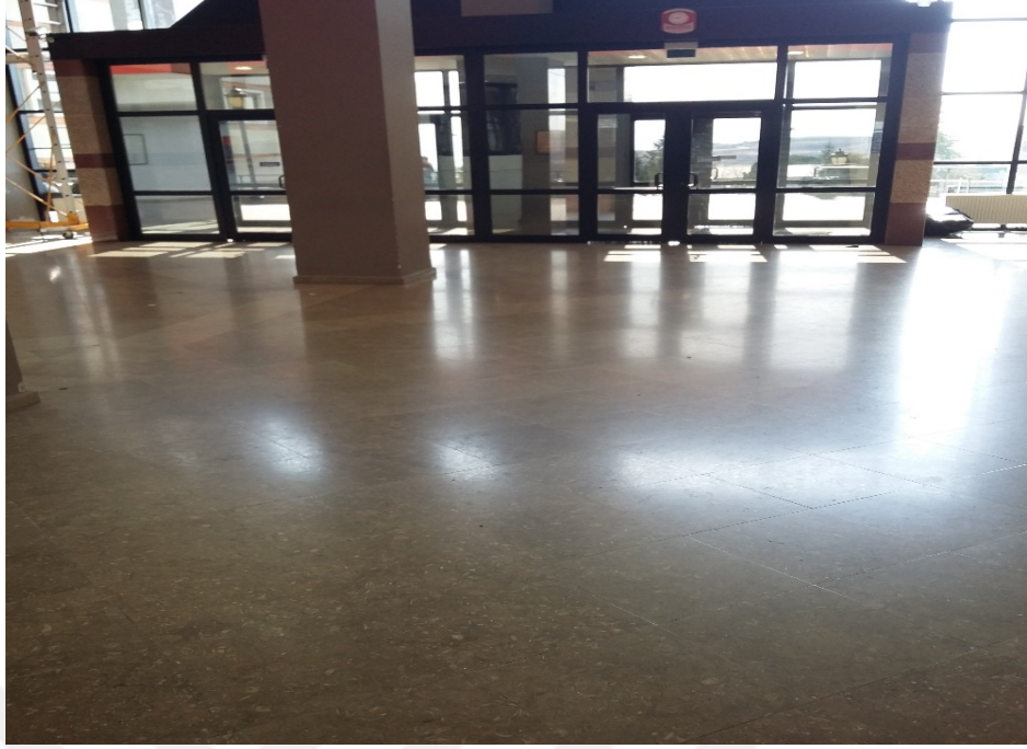
Şekil 4.10. Mühendislik Fakültesi A Blok giriş kapısı ve acil tahliye kapısı.
