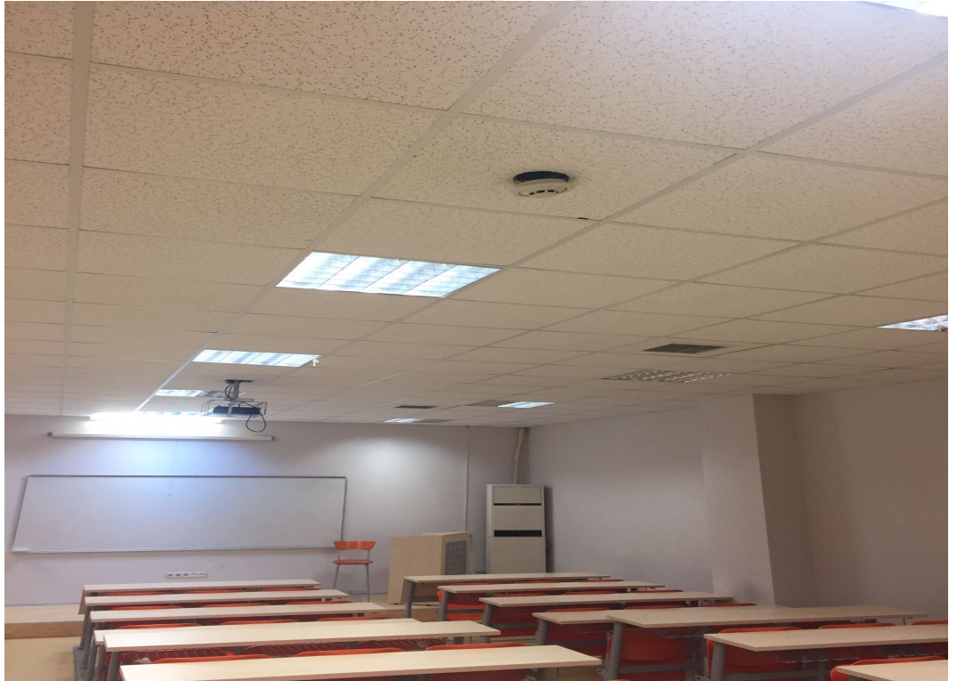
Şekil 4.14. Yuvasından çıkmış duman dedektörü.
