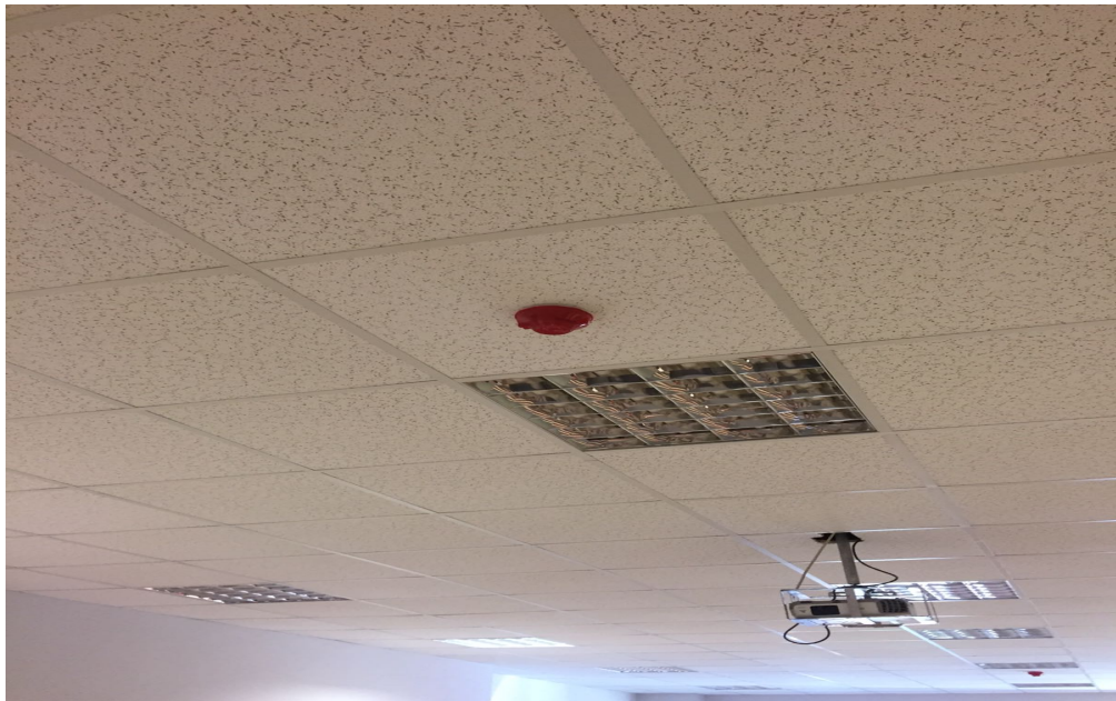
Şekil 4.22. Yanıcı malzeme arasından rastgele sarkıtılmış kablolar.
