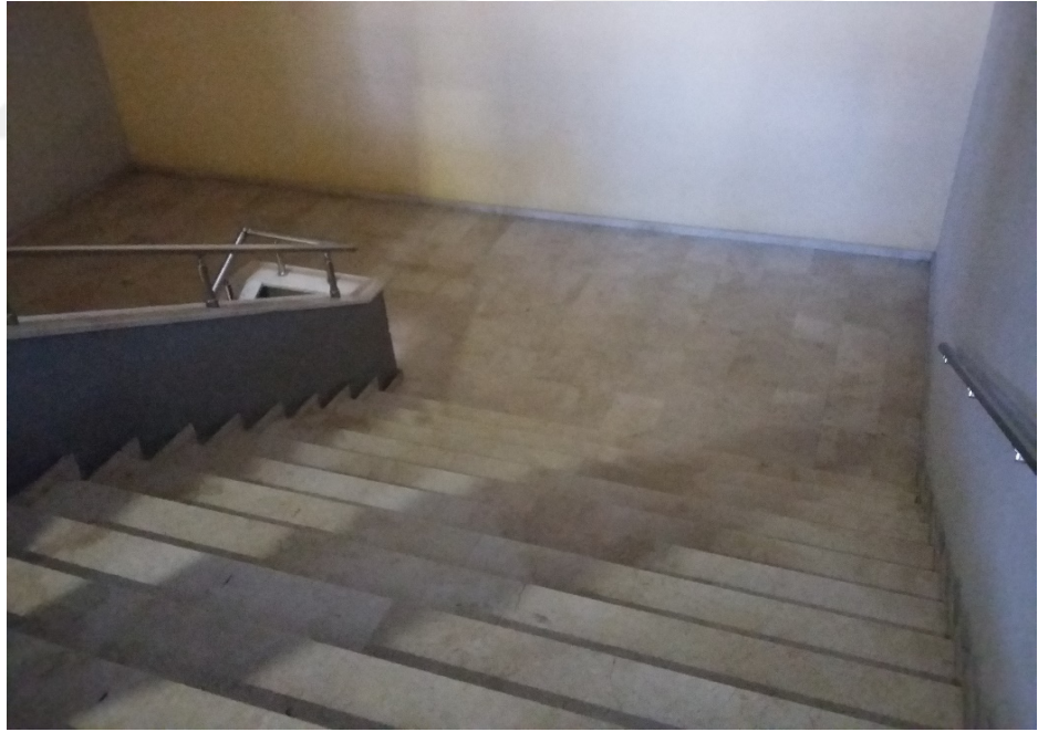
Şekil 4.11. Mühendislik Fakültesi A Blok giriş kapısı ve acil tahliye merdiveni.
