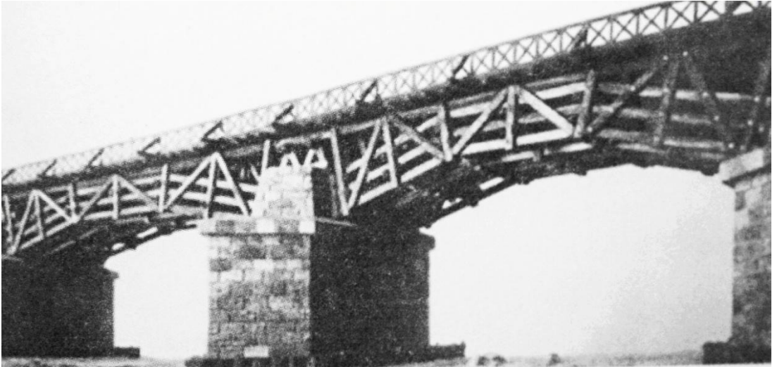
Resim 3. Taş Temelli Ahşap Köprü
