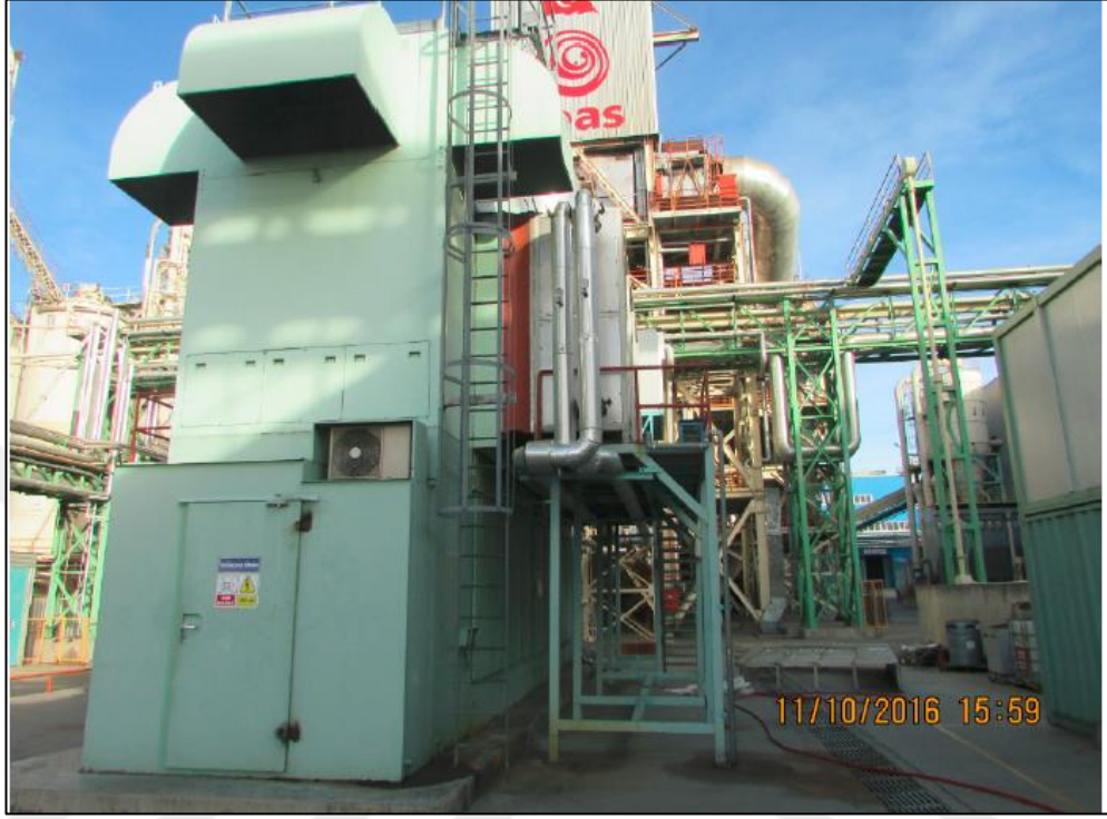
Şekil 4.4. Uygulama sonrası fotoğrafı
