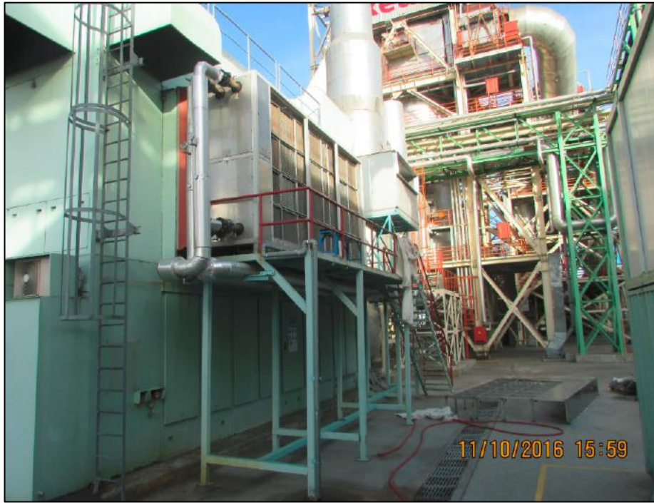
Şekil 4.5. Uygulama sonrası fotoğrafı
