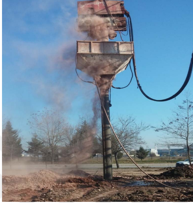
Şekil 3.20. Taş kolon virasyonu
