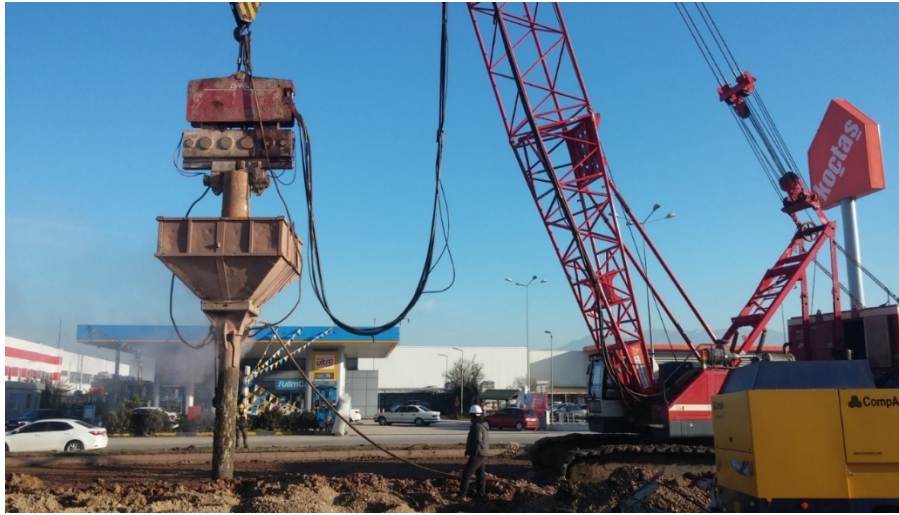
Şekil 3.21 Taş kolonun ikinci kademesi
