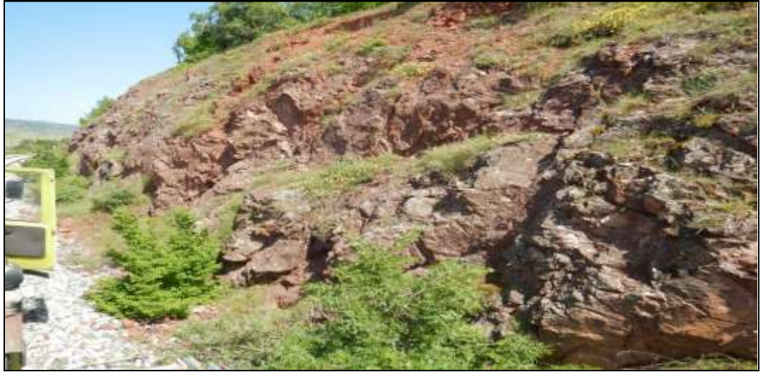
Şekil 2.3. Km: 236+100 Karakaya formasyonuna ait çamurtaşı ve kilaşının mevcut demiryolu yarmasında görünümü
