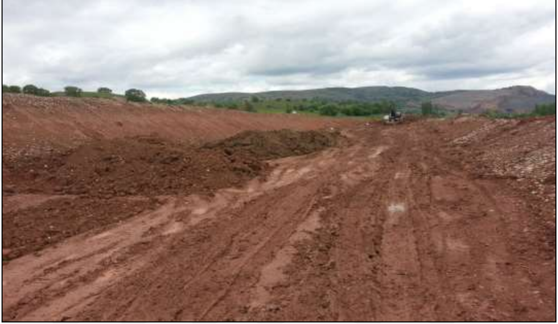
Şekil 3.5. Güzergâh üzerinde karşılaşılan zayıf zemin görünümü
