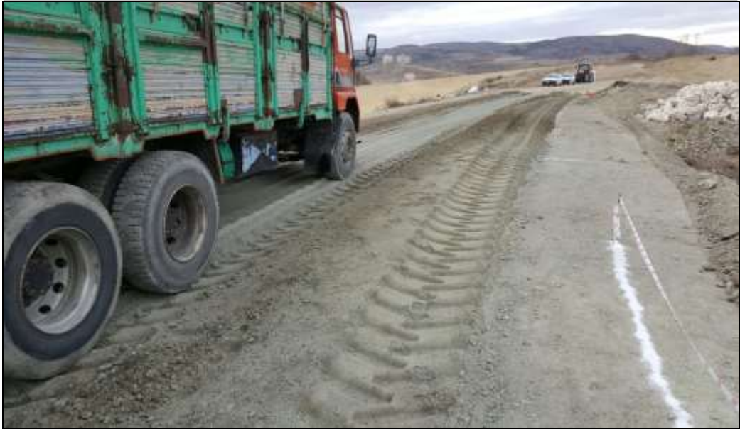
Şekil 3.7. Frezeleme işlemi/ çimento serimi
