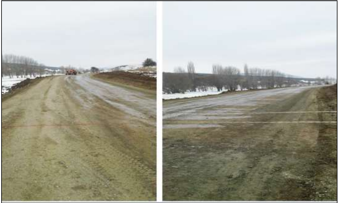
Şekil 3.9. Sıkıştırmadan sonra NovoCrete tabakasını sulama işlemi
