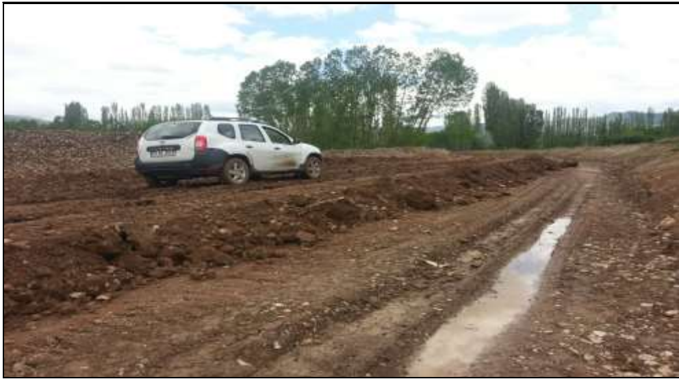
Şekil 3.4. Yeraltı su seviyesi platform düzeyinde olan çalışma alanının görünümü
