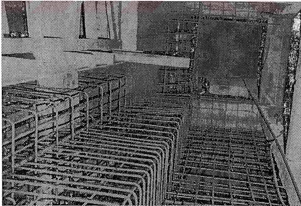
Şekil 7.19. Hasar gören temelin güçlendirilmesi
