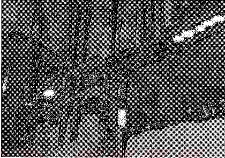
Şekil 7.13. Çelik lamalar sarılarak güçlendirilmiş birleşim bölgesi
