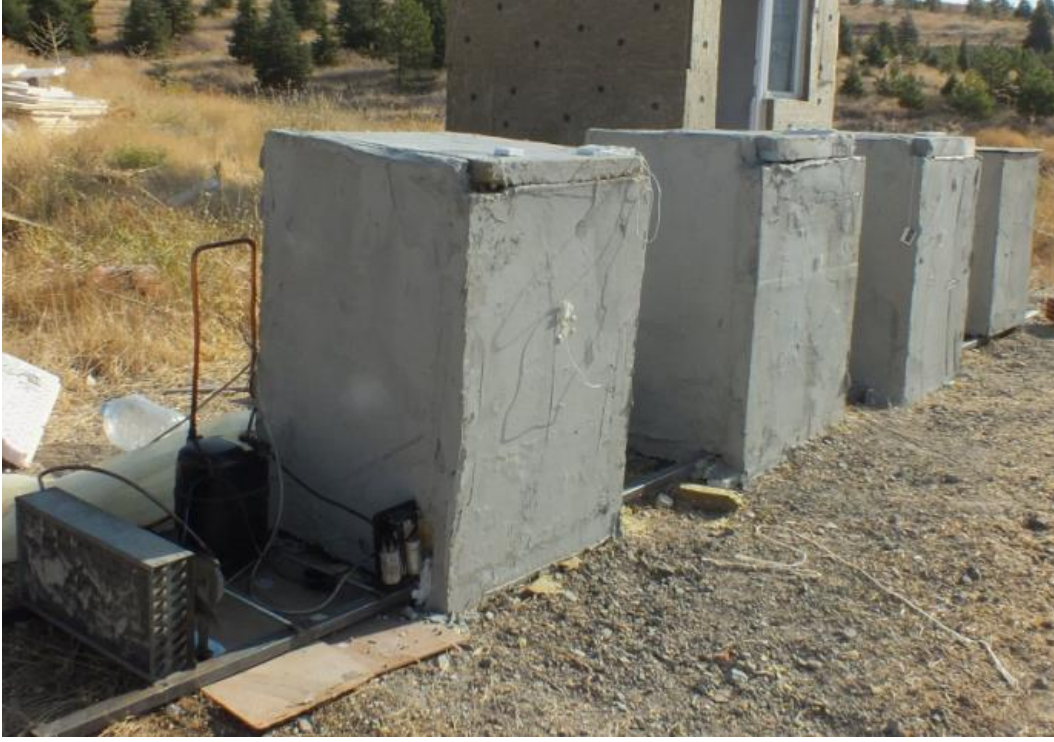
Şekil 2.9. Deney odalarının yalıtımının yapım aşamasının görünüşü
