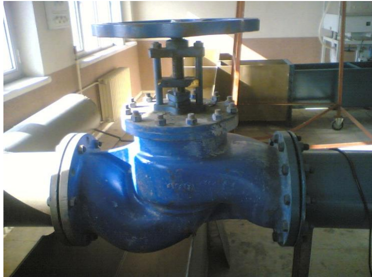
Şekil 5.5. Giriş debisinin ayarlandığı debimetrenin ön kısmındaki vana
