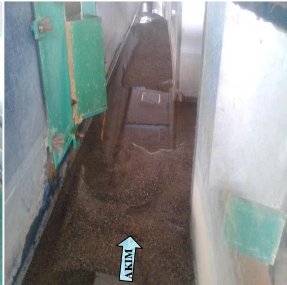
Toplama Kanalından görünüm
