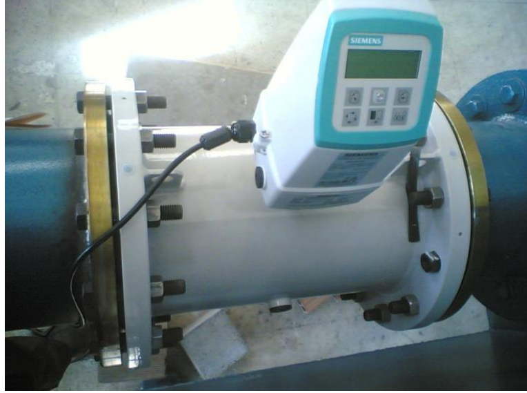
Şekil 5.4. Giriş debisini ölçen elektromanyetik debimetre
