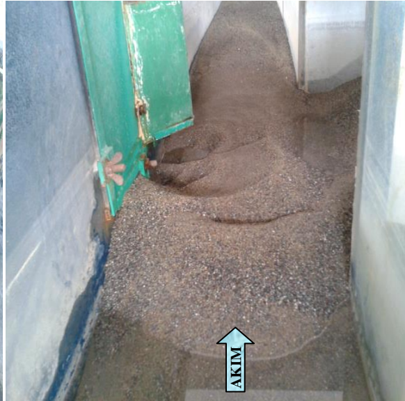
Toplama Kanalından görünüm
