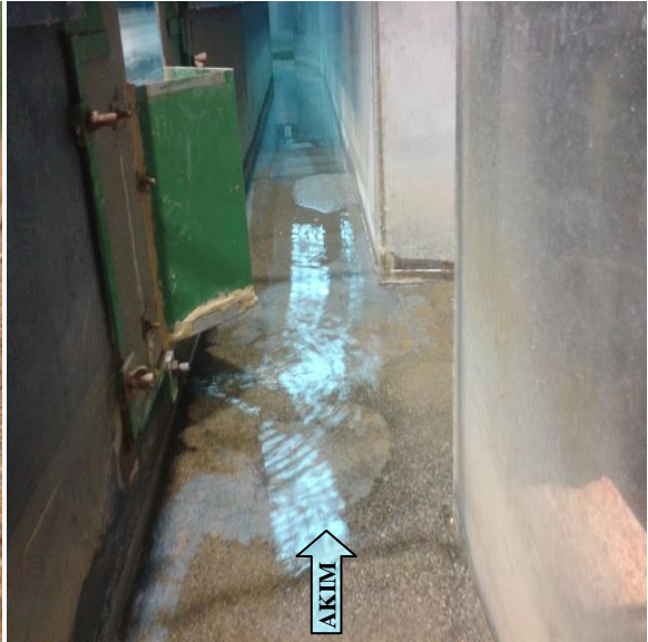
Toplama Kanalından görünüm
