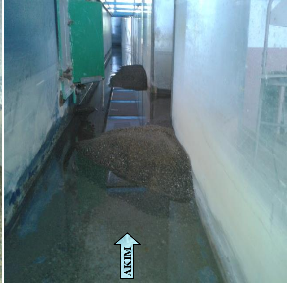
Toplama Kanalından görünüm
