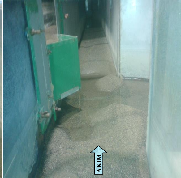
Toplama Kanalından görünüm
