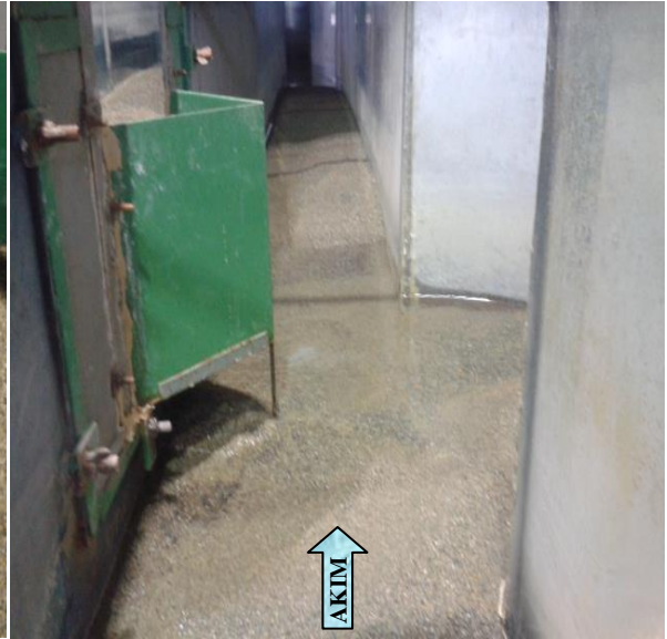
Toplama Kanalından görünüm
