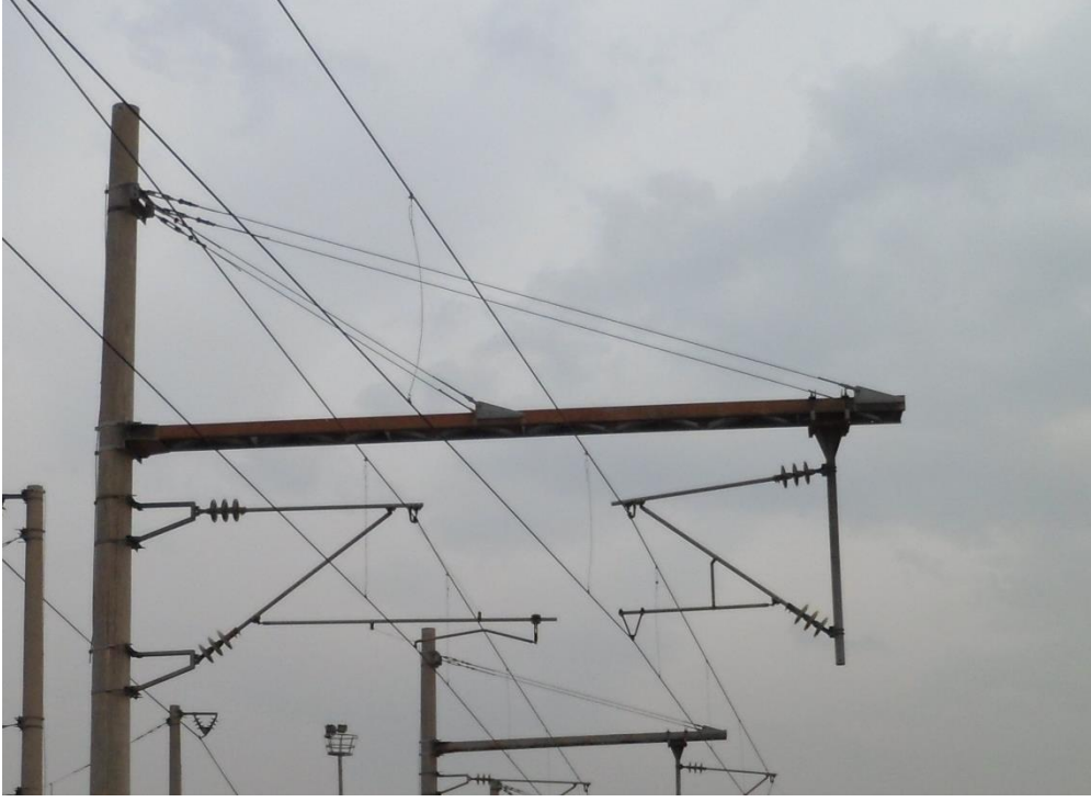
Şekil 2.7. Gerçek bir katener sisteminin konsol-hoban donanımı
