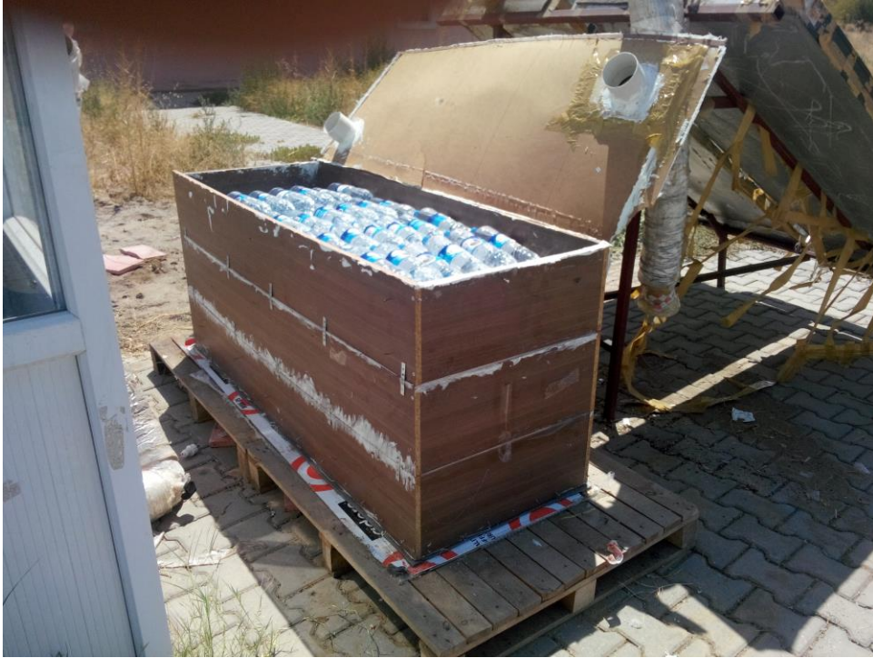
Şekil 7.3.b. Isı deposunun görünümü
