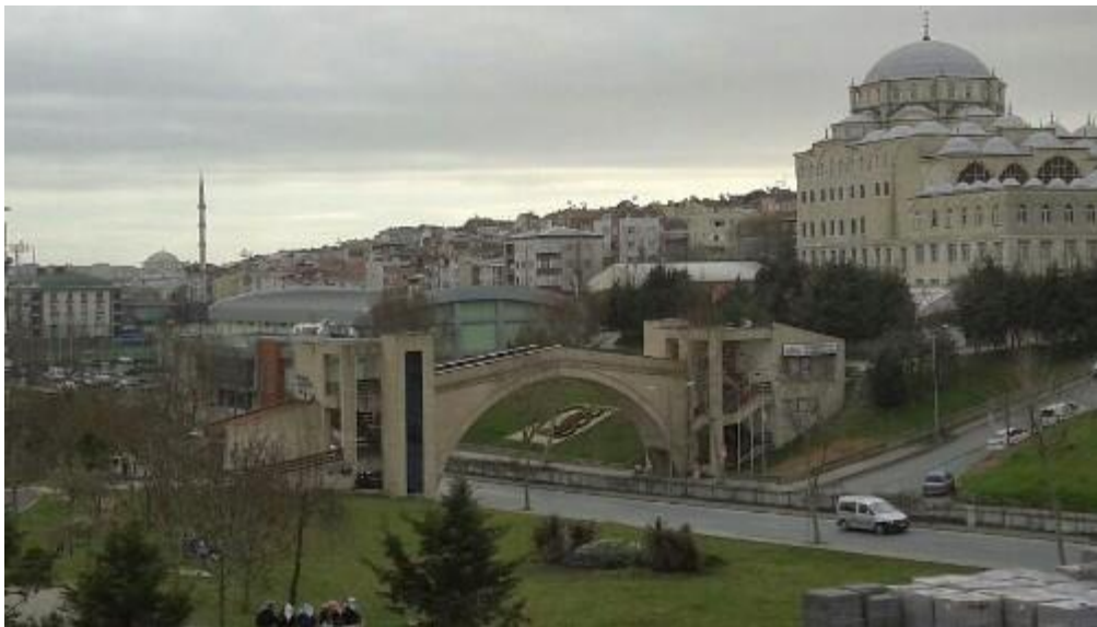
Resim-2: Bayrampaşa İlçesi, Kocatepe Mahallesi'ndeki Mostar Köprüsü
