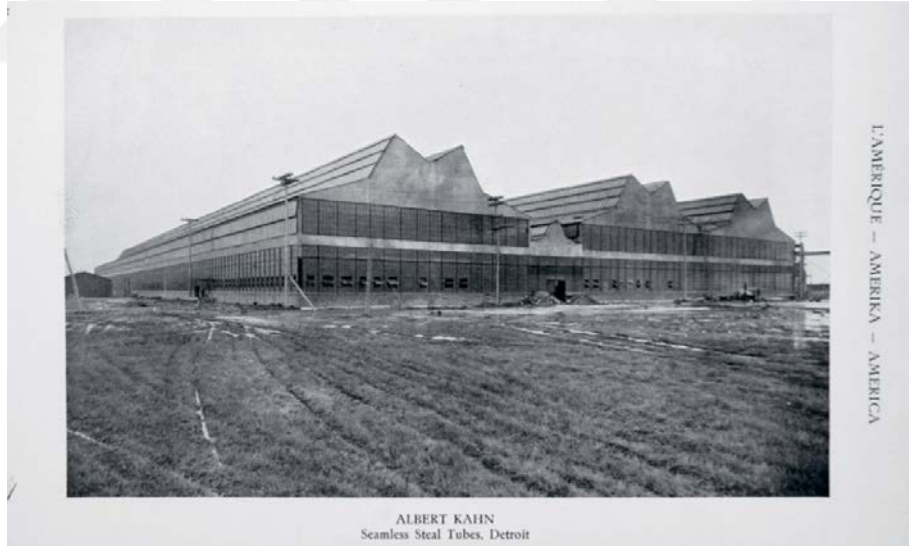
Şekil 3.13. Tasarımı Albert Kahn'a ait Detroit Seamless Steel Tubes Company Fabrikası, Detroit. Adolf Behne Arşivi, Der moderne Zweckbau (Munich: Drei Masken Verlag, 1926)
