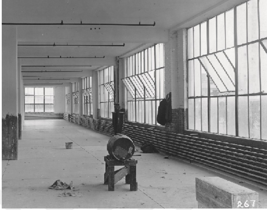
Şekil 3.12. Tasarımı Albert Kahn'a ait Packard Motor Car Company Fabrikası iç mekânı, Detroit, 1919, Bentley Tarih Kütüphanesi, / © Albert Kahn Associates
