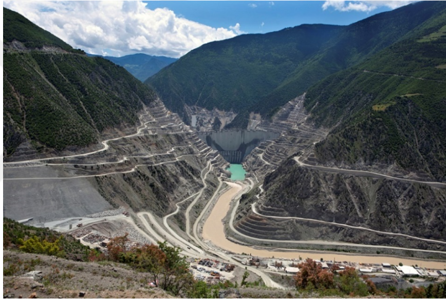
Şekil 3.36. Artvin Deriner Barajı. Fotoğraf: Saner Şen (URL-23)
