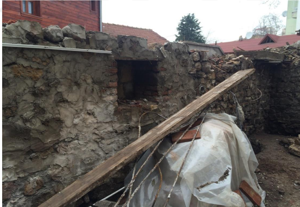
Şekil 4.10. Bodrum kat batı duvarı
