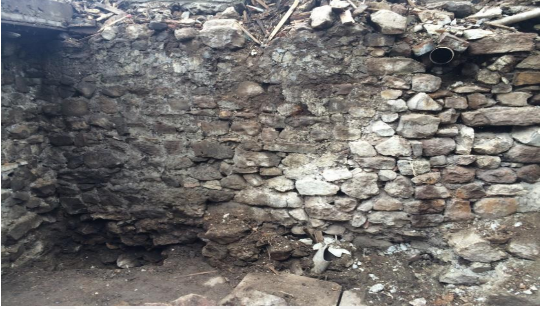
Şekil 4.7. Bodrum kat arkası toprak olan kuzey duvarı ve köşesinde açılan temel muayene çukuru
