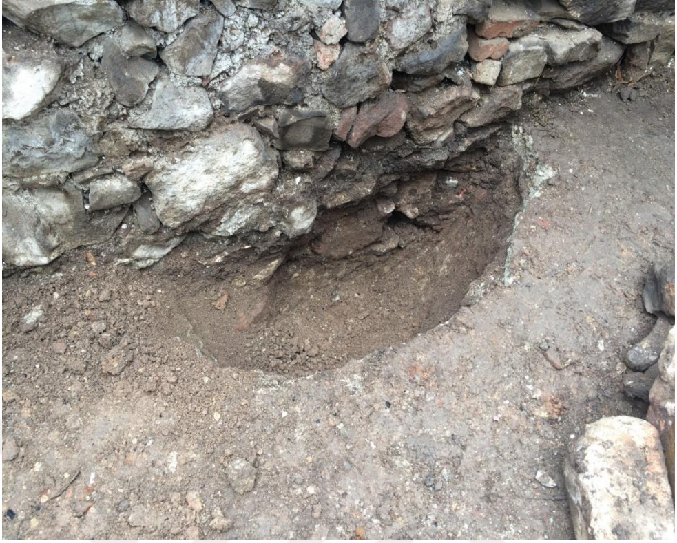
Şekil 4.9. Batı duvarında açılan temel muayene çukuru
