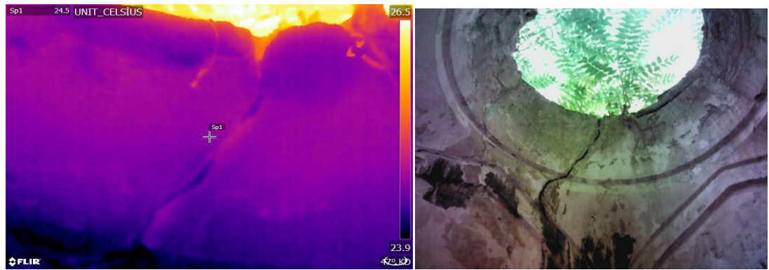
Şekil 4.24. Sıcaklık mekânı güneydoğu yıkılmış küçük kubbe ve yapısal çatlak ve yüzey sıcaklık görseli
