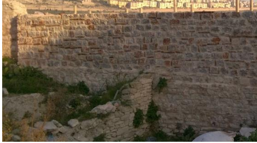
Şekil 4.53. doğu sur duvarları yatay hatlı sıraları
