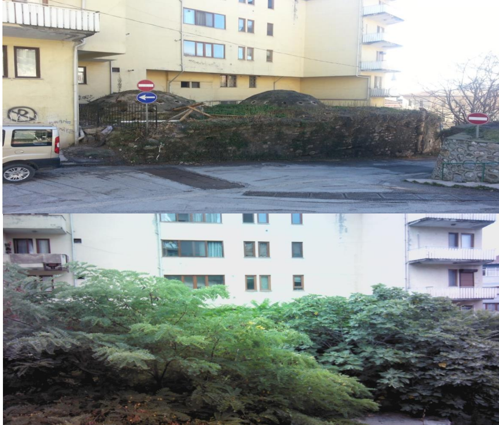
Şekil 4.21. Şubat ve Ağustos aylarında yapı kubbe kotunda bulunan bitkiler
