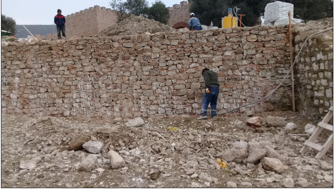
Şekil 4.60. Enjeksiyon çalışmaları
