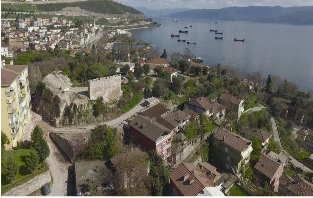
Şekil 4.45. Hereke Kalesi restorasyon öncesi hali
