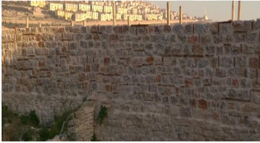
Şekil 4.54. Doğu sur duvarları
