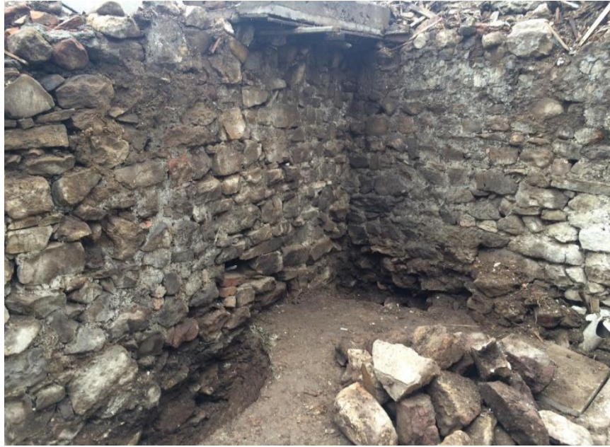
Şekil 4.8. Bodrum kat batı (soldaki) ve kuzey (sağdaki) duvarı
