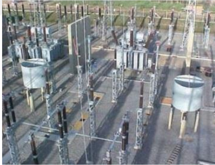
Şekil 2.20. Hava çekirdekli nötr reaktörleri [53]
