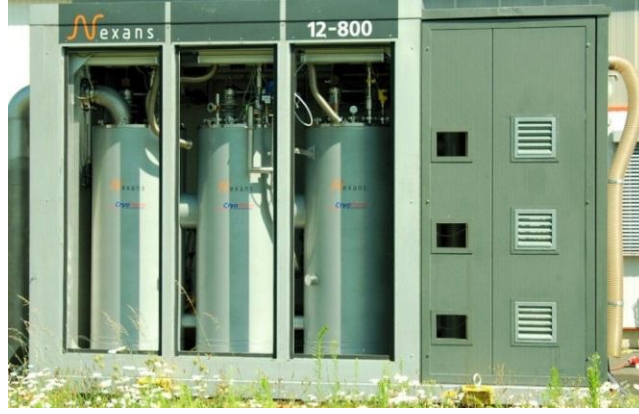
Şekil 3.18. 12 kV 800 A SFCL [68]
