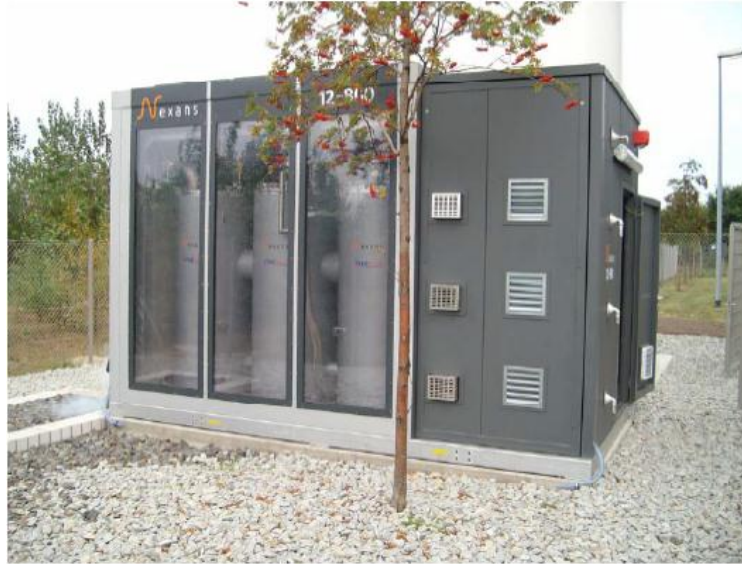
Şekil 3.17. 12 kV 800 A SFCL [67]
