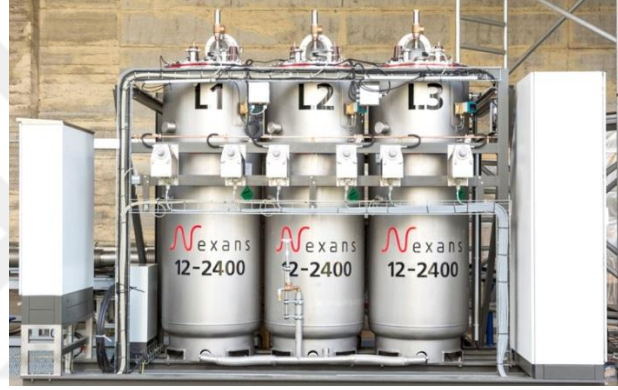
Şekil 3.19. 12 kV 2400 A SFCL [69]
