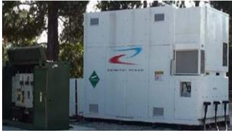
Şekil 3.15. 15 kV Saturable-Core SFCL uygulaması [1]
