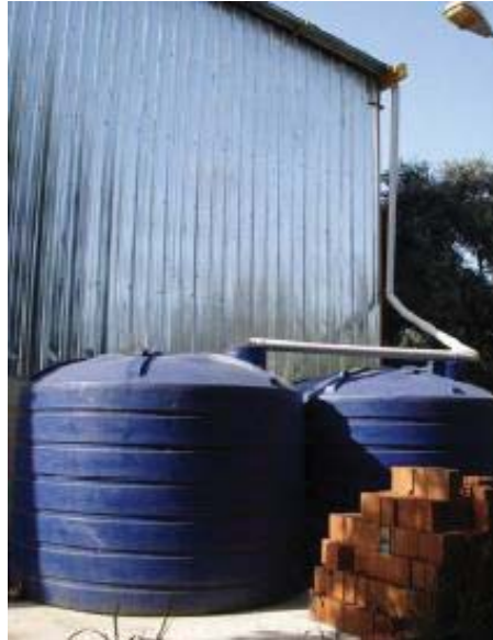
Şekil 2.14. a) Toprak nem sensörü, b) Çatı saçak sularının toplanarak depolanması (Anonim 2013k, Taner 2010)
