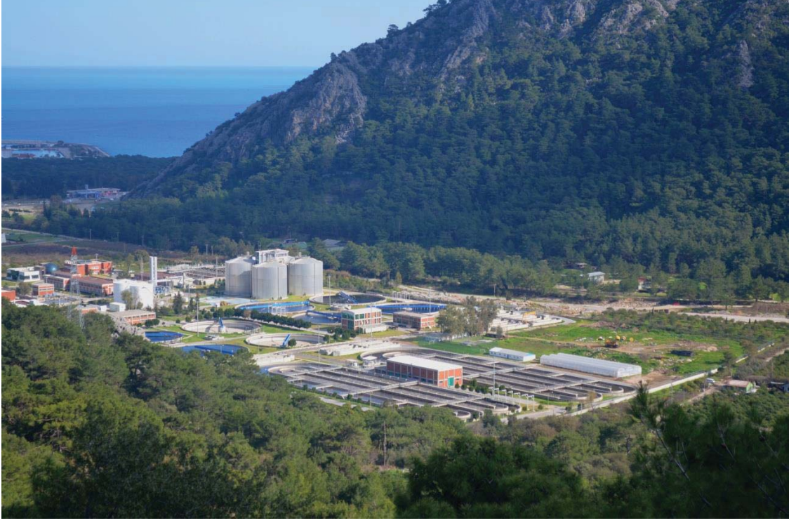
Şekil 4.11. Hurma Atıksu Arıtma Tesisleri (Özgün 2015)
