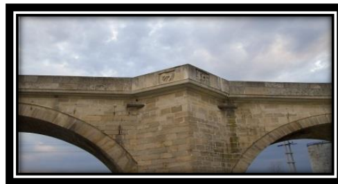
Şekil 2.3. Uzunköprü Kemer Duvarlarındaki Taş Süslemeler
