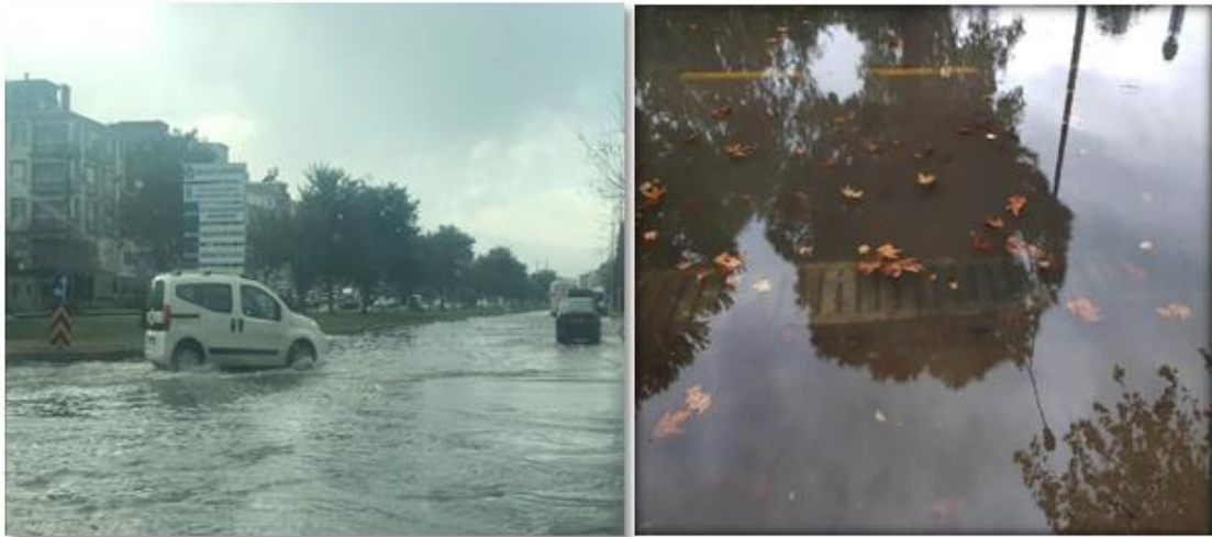
Şekil 1. 1. Aşırı yağış sonrası yollardaki drenaj problemleri
