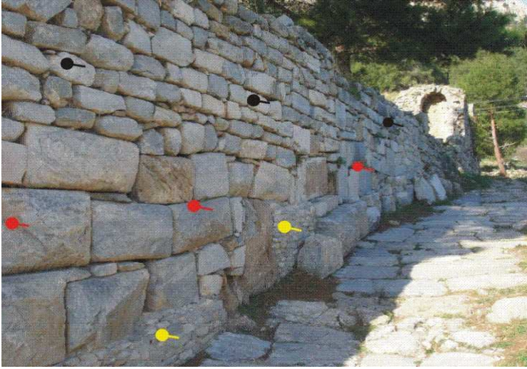
Şekil 4.14. Yukarı gymnasium'un doğu duvarında gözlenen farklı yapım aşamaları. Duvar üzerinde sarı, kırmızı ve mavi ile gösterilen bölümler farklı yapı taşlarından inşa edilen bölümleri göstermektedir. Bu bölümler duvar üzerinde en az iki restorasyonun olduğunu göstermektedir.
