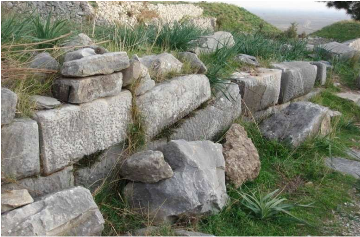
Şekil 4.15. K-G yönlü cadde duvarının kuzeye eğimlenmiş ve deforme olmuş blokları (Bakış yönü GD'dur).
