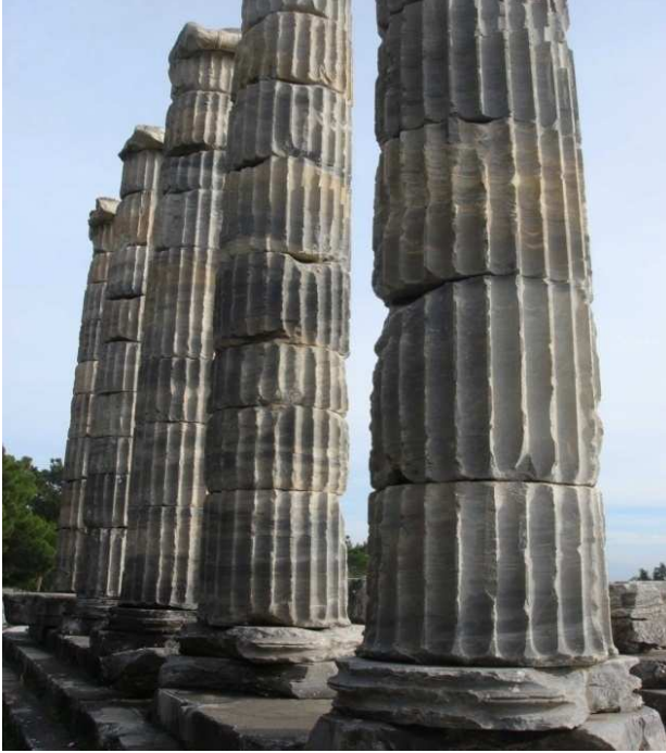
Şekil 4.10. Athena tapınağının sütunlarında gözlenen sarsıntıya bağlı deformasyon izleri. Tarihsel döneme ait bir depremin sarsıntıları sonucunda tamburların kenarlarında meydana gelmiş olan kırık ve patlaklar.
