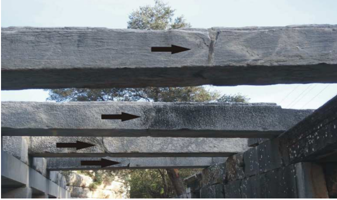
Şekil 4.8. Tiyatro sahnesinin restorasyon ile birleştirilmiş tavan elemanları. Yapı taşlarının tümünün orta noktalarında gözlenen kırıklar, tiyatronun bu bölümünün tarihsel dönemlerde meydana gelmiş olan bir depremin sarsıntıları sonucu yıkıldığını ve bu taşların üzerlerine düşen diğer yapı elemanları sonucu kırıldığını göstermektedir.
