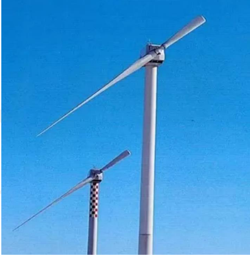
Şekil 1.13. Tek kanatlı yatay eksenli rüzgâr türbini
