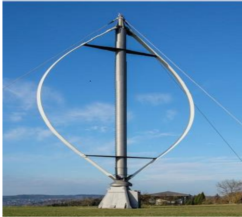
Şekil 1.17. Darrieus tip dikey eksenli rüzgâr türbini
