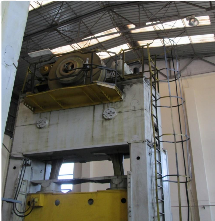
Şekil 3.34. Pres üzerine çıkan merdivene sepet korkuluk uygulaması
