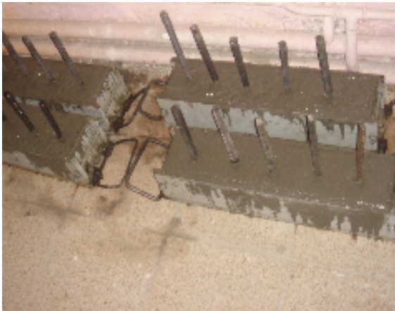
Şekil 5.7.2. Alt başlıkların hazırlanışı
