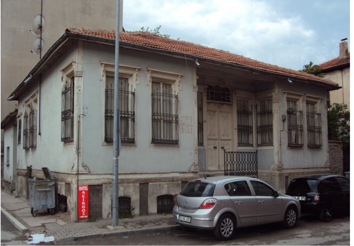
Resim 6.4. Edirne Kaleiçi bölgesinde ki evlerde çatı uygulaması..
