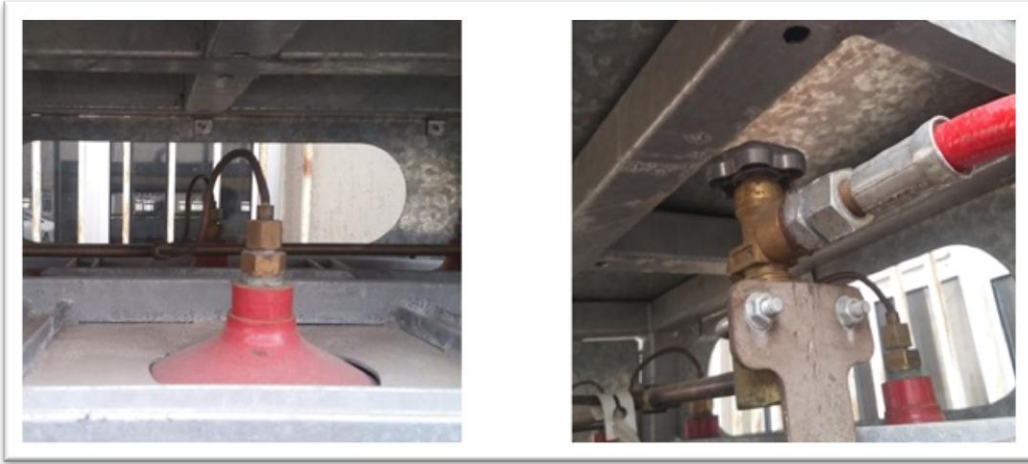
Şekil 8.15. CNG Tüp Demeti Manifold Çıkış Vanası
