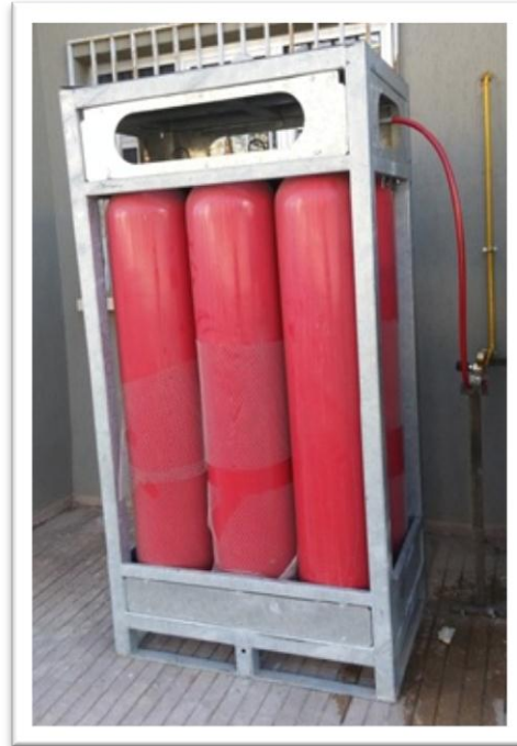
Şekil 8.17. CNG Tesisatındaki Yüksek Basınç Dayanımlı Flex Hortumun Bağlantısı
