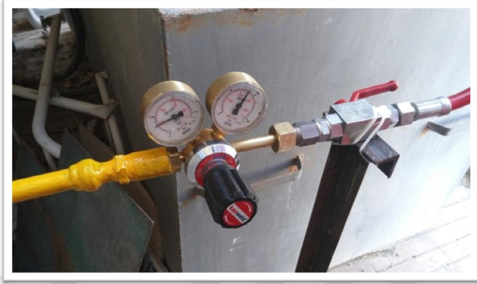
Şekil 8.18. Yüksek Debili Basınç Düşürücü Gaz Armatürü
