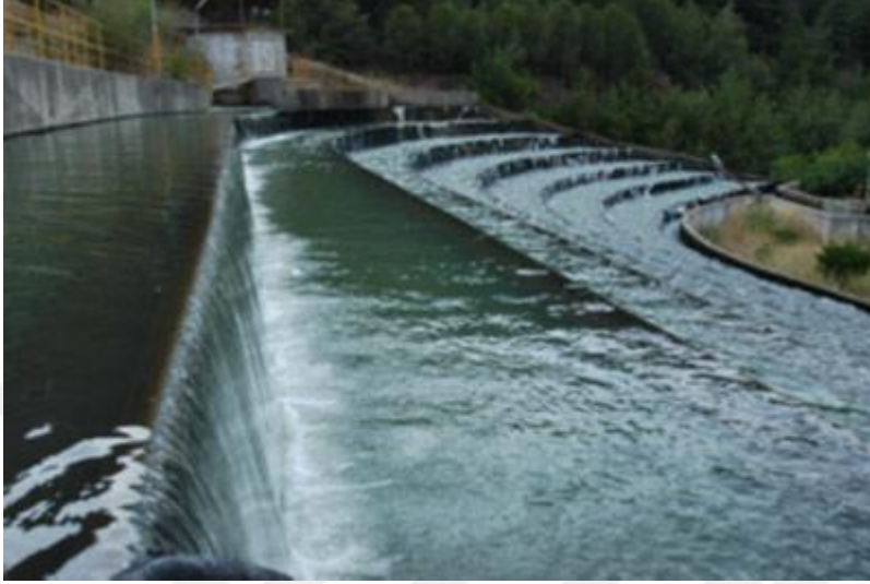
Şekil 2.2. Balçova Barajı Havalandırma Kaskatları ( www.izsu.gov.tr )
