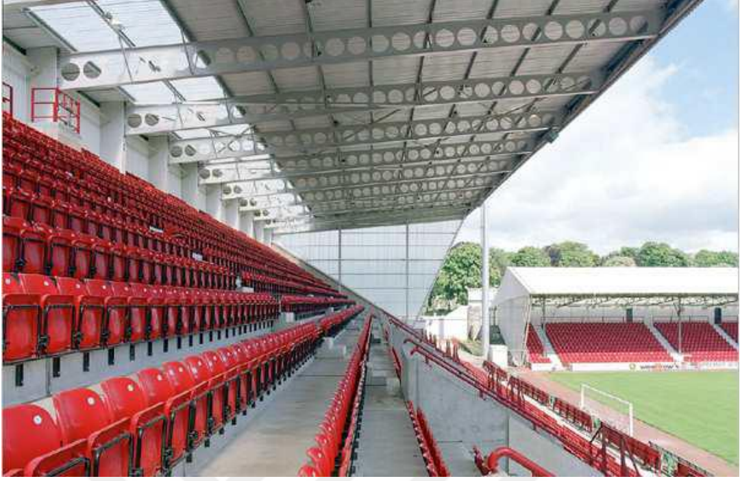
Şekil 1.7. Bir stadyumda petek kirişlerin konsol dizaynı, Dumferline [3]
