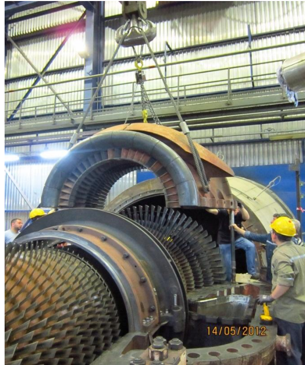
Şekil 6.28. Türbin Sabit Kanat taşıyıcı Üst Parçanın Yerinden Alınması
