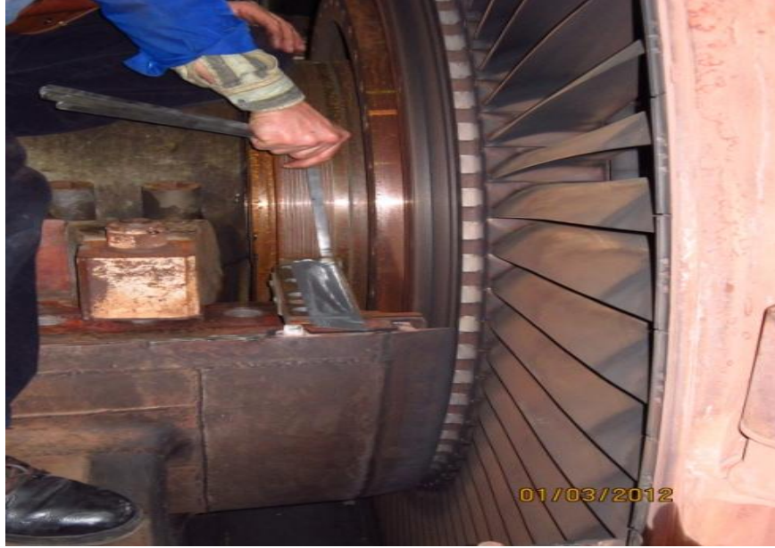
Şekil 6.17. Gaz Türbini 5. Kademe Ölçülerin Alınması
