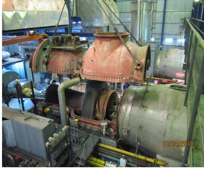
Şekil 6.16. Gaz Türbini Sabit Kanat Taşıyıcı Üst Parça
