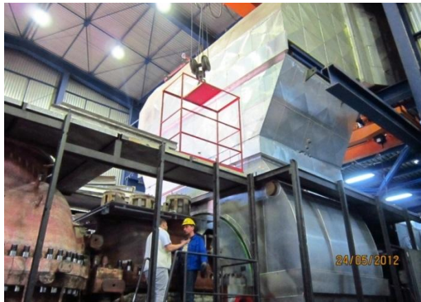
Şekil 6.60. Hava Emiş Alt ve Üst Parçalar
