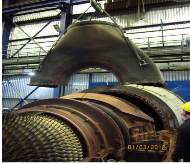
Şekil 6.22. Sıcak Gaz Kabini Üst Parça
