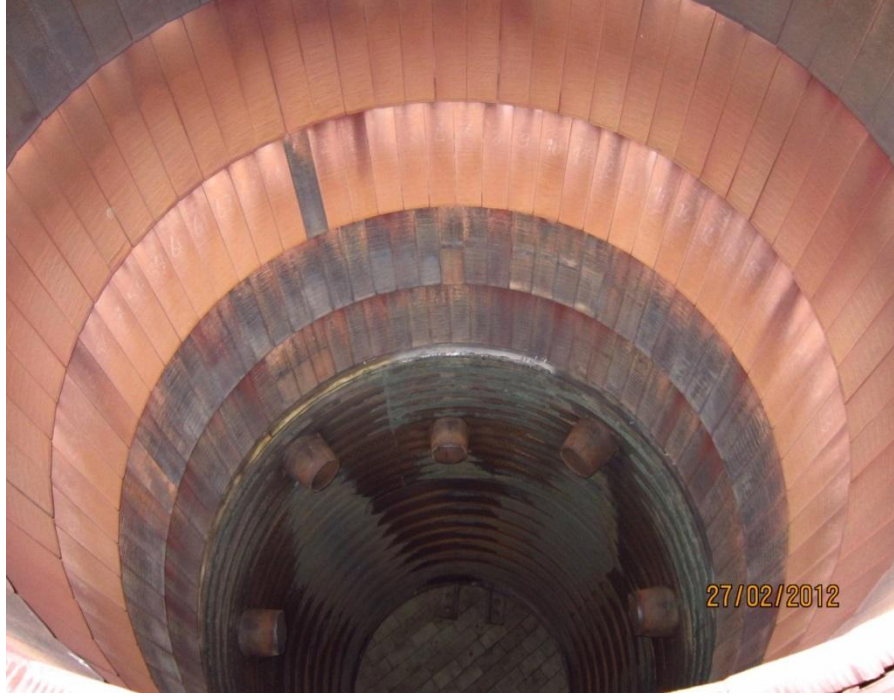
Şekil 4.6. Yanma Odası Tuğlalar ve İç Tüp
