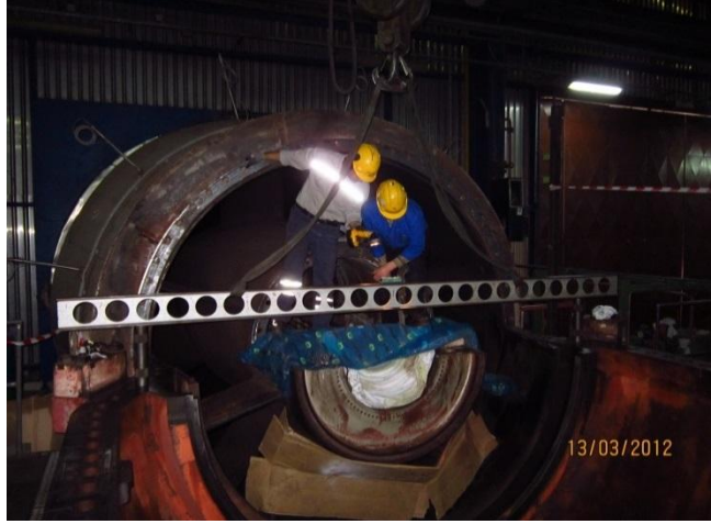
Şekil 6.45. Türbin Kasasının Terazi Ölçüsünün Alınması
