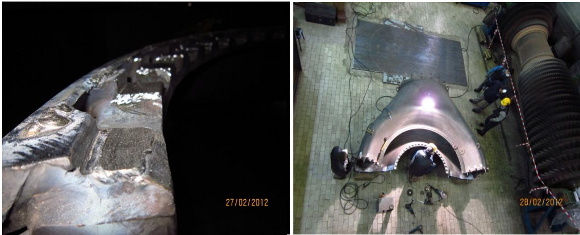
Şekil 6.41. (a) Sıcak Gaz Kabini Basma Plakası (b) Sıcak Gaz Kabini Tamir Çalışması
