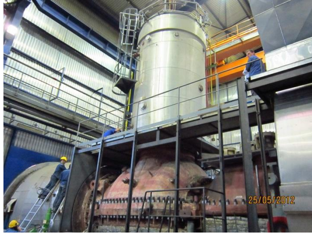
Şekil 6.58. Yanma Odasının Yerine Konulması
