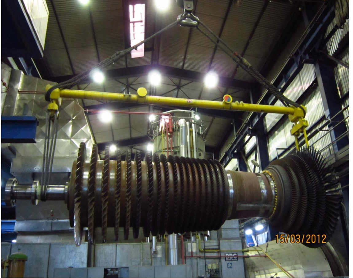
Şekil 3.1. Gaz Türbini - Kompresör Rotoru
