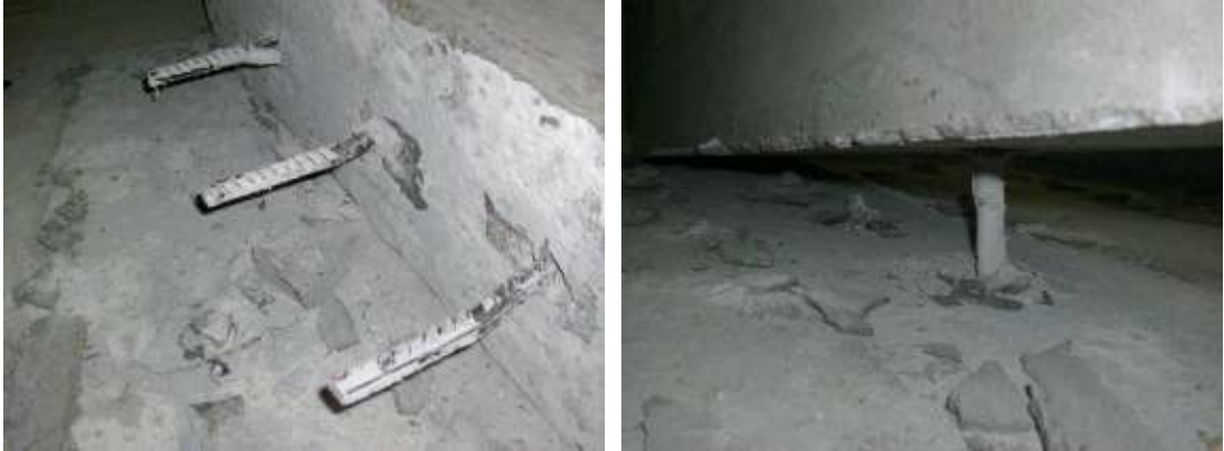
Şekil 4.4. Deney sırasında oluşan hasarlar
