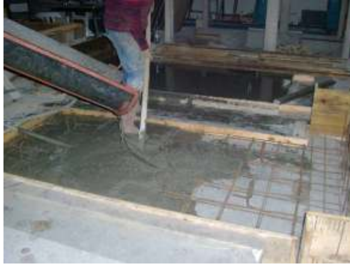
Şekil 5.10. Perdelerin beton dökümü
