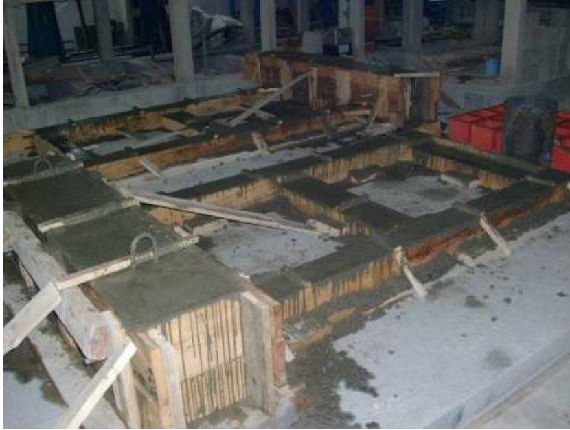
řekil 5.8. revelerin beton dkmnden grnt
