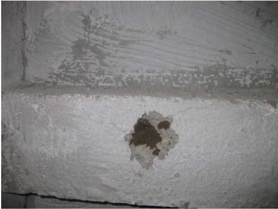
Şekil 6.10. Kirişte konik kopma
