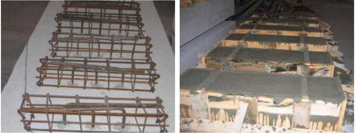
Şekil 3.16. Beton blokların donatıları ve beton dökümü
