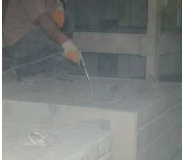
Şekil 3.14. Ankraj deliklerinin temizlenmesi
