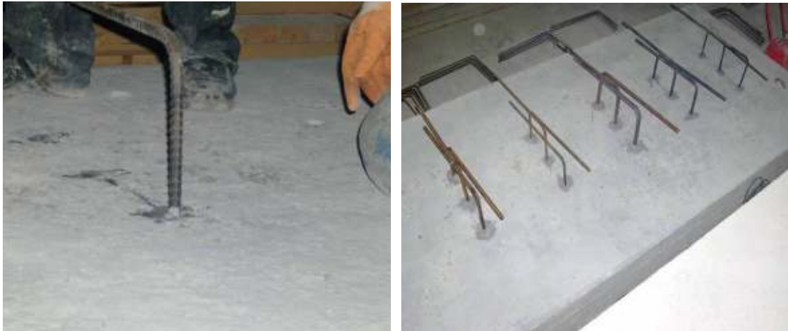
Şekil 3.15. Ankrajların ekilmesi
