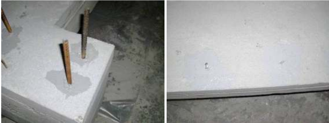
Şekil 5.11. Perde – çerçeve bağlantı ankrajlarının ekimi
