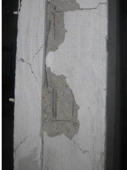
Şekil 6.9. Kolonda konik kopma
