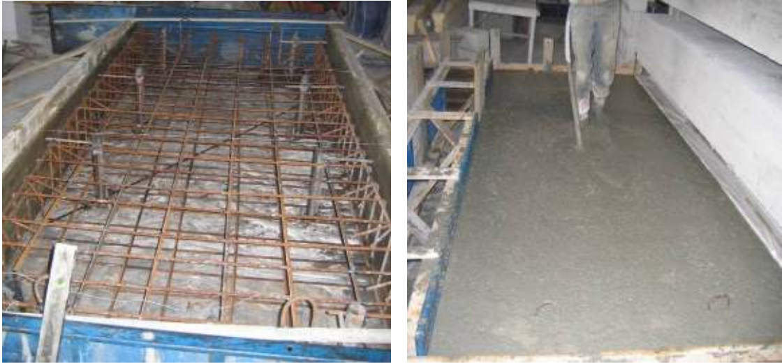
Şekil 3.13. Temellerin donatıları ve beton dökümü
