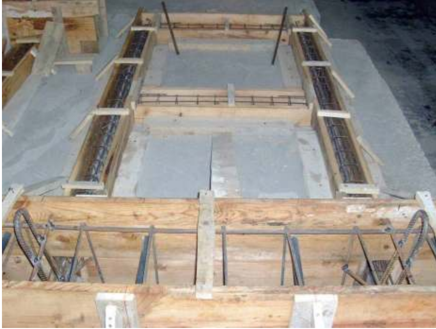
Şekil 5.7. Çerçeve kalıbı
