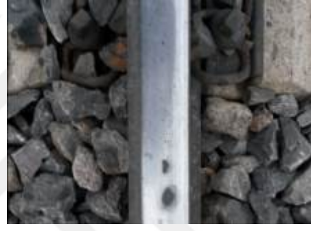
d) DN olarak sınıflandırılan arızalı bir çerçeve
