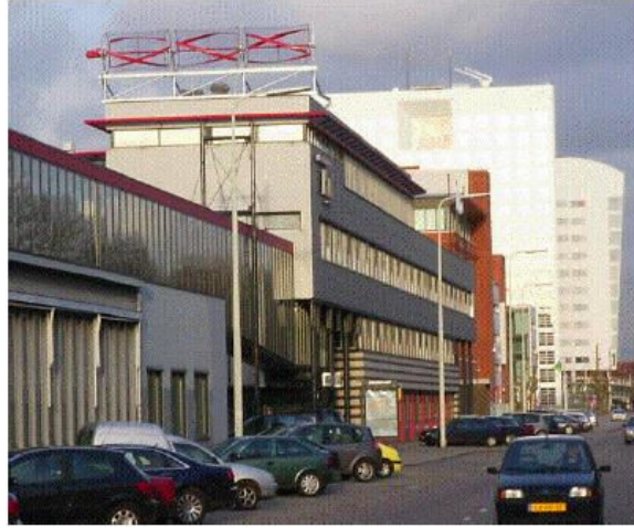
Şekil 3.29. Çatıya monte rüzgâr türbini (URL-26)
