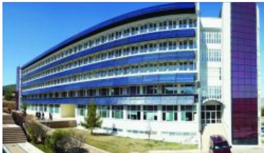
Şekil 3.22. Muğla Üniversitesi Rektörlüğü cephe bütünleşik güneş pilleri (URL-21)
