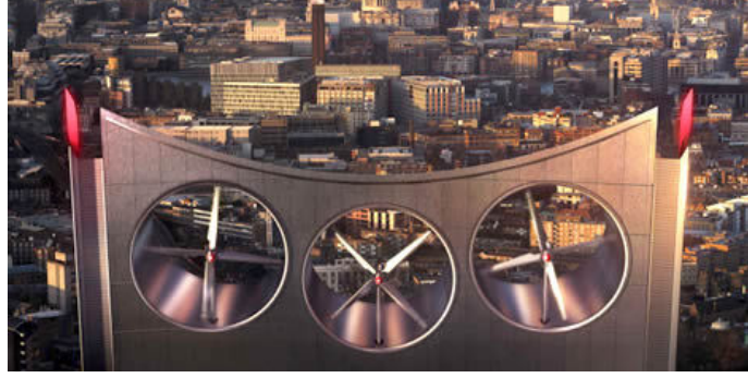
3.31. Strata Konut Binası (URL-28)
