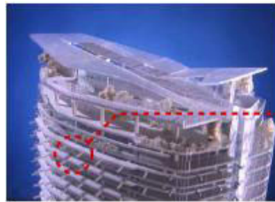
Şekil 3.3. Yee Nen Tower binası cephe bütünleşik ışık tüpleri (Yeang, 2003)
