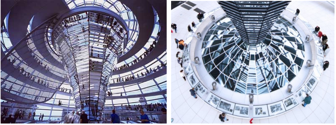
Şekil 4.12. Kubbe: a) güneş kontrol elemanı ve rampa, b) gezi platformu (URL-39)
