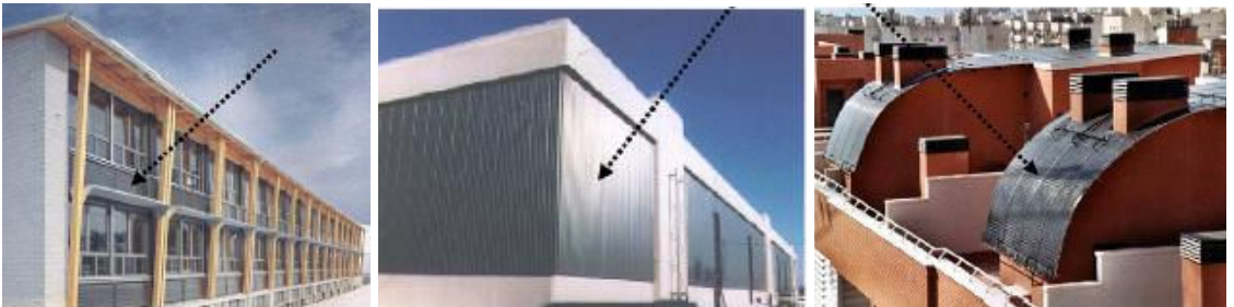
Şekil 3.23. Bina bütünleşik kolektör uygulamaları; a) parapet örneği, b) cephe örneği, c) eğimli çatı örneği (URL-22)
