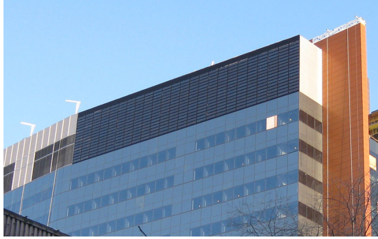
Şekil 3.27. Concordia Üniversitesi John Molson İşletme Bölümü binası bina bütünleşik PV/T cephe uygulaması (URL-24)
