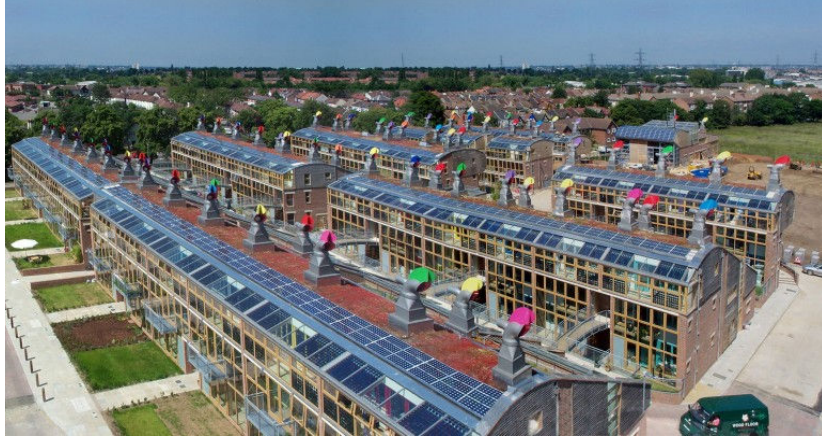
Şekil 3.6. BedZed güneş odası (URL-11)
