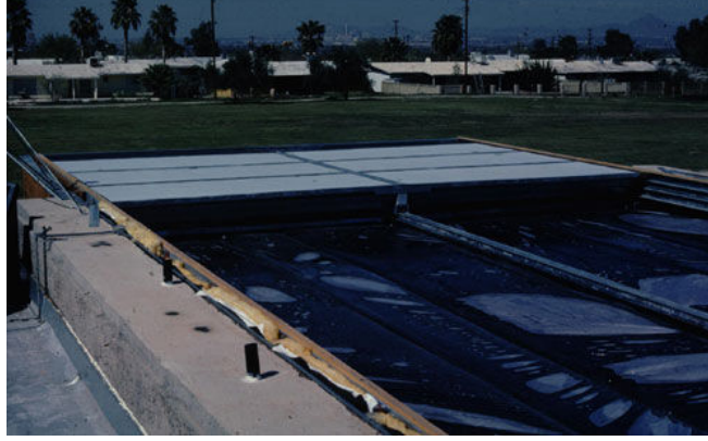
Şekil 3.7. Arizona güneş merkezinin yaptırdığı çatı havuzu (URL-12)
