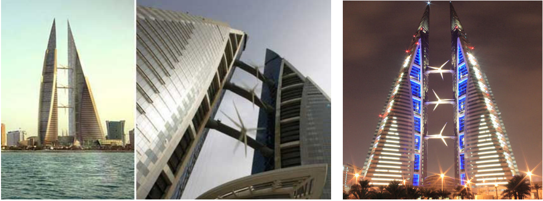
Şekil 3.30. Bahreyn Dünya Ticaret Merkezi Binası (URL-27)
