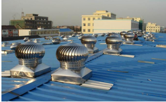
Şekil 3.12. Rüzgâr gücü ile çalışan türbin vantilatör (URL-15)
