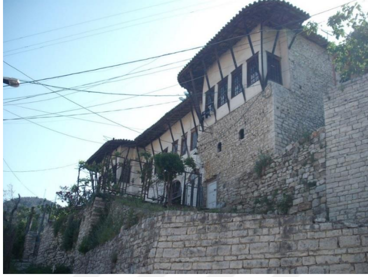
Şekil 4.21. Çatıyı desteklemek için kullanılan payandalar
