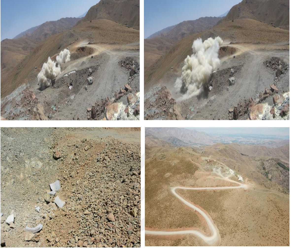
Şekil 4.4. Birinci Sistemin Patlatılması
