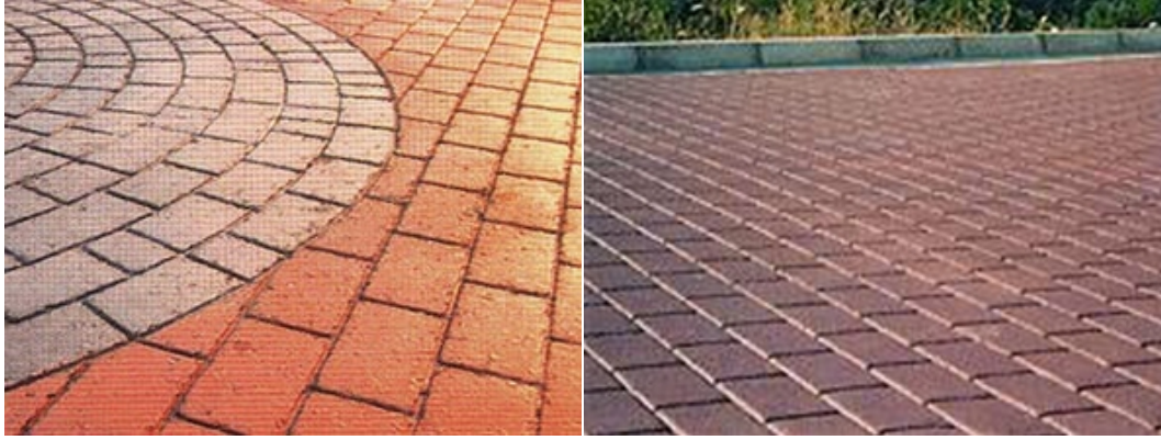
Şekil 7.7. Renkli ve desenli asfalt uygulamaları
